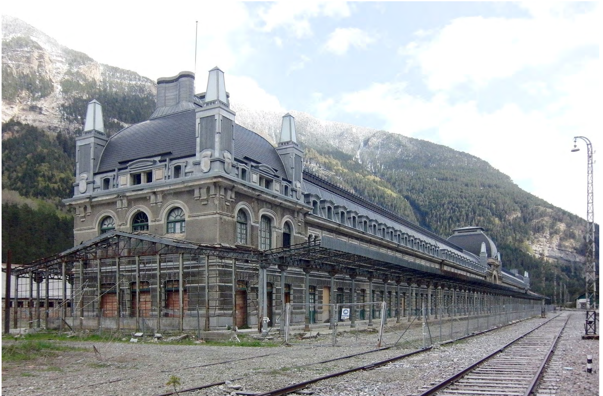
oben + auf den nächsten zwei Seiten: Im Zuge der Renovierungsarbeiten sollte der Bahnhof ursprünglich ein zusätzliches Stockwerk mit verglaster Fassade erhalten. Stattdessen wurde nur das Dach erneuert – für weitere Umbauarbeiten fehlt bislang das Geld. Fotos: Matthias Maas, 2010
