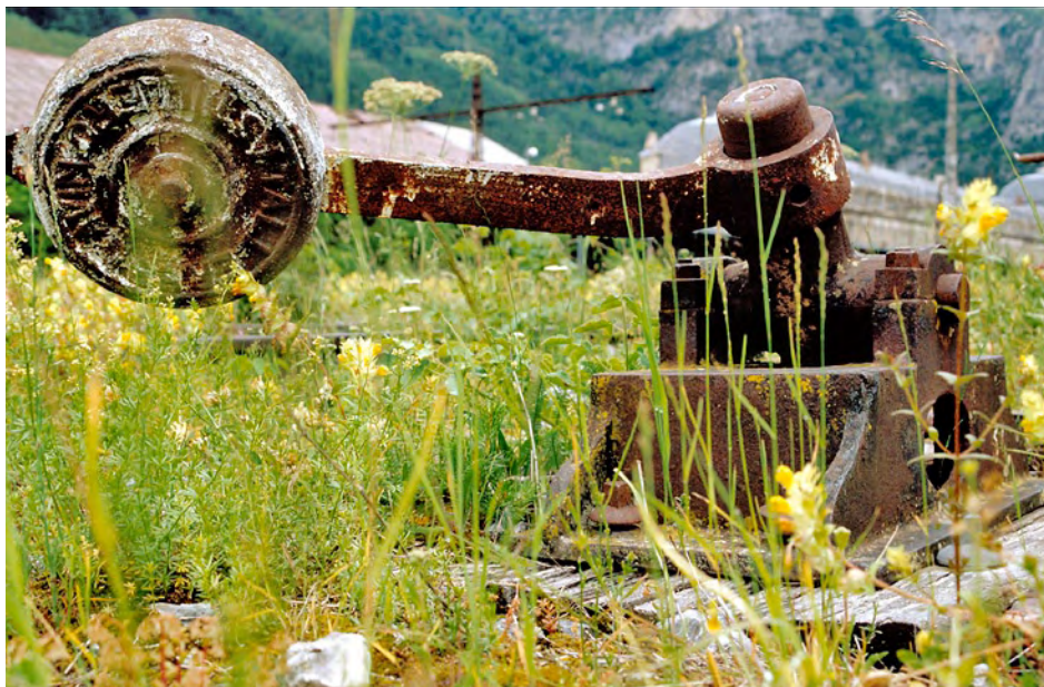
Viele der heute noch vorhandenen Gleis- und Sicherungsanlagen sind technisch veraltet, abgenutzt oder abgebaut, das Trasse ist stellenweise beschädigt. Foto: Stefan Gregor
