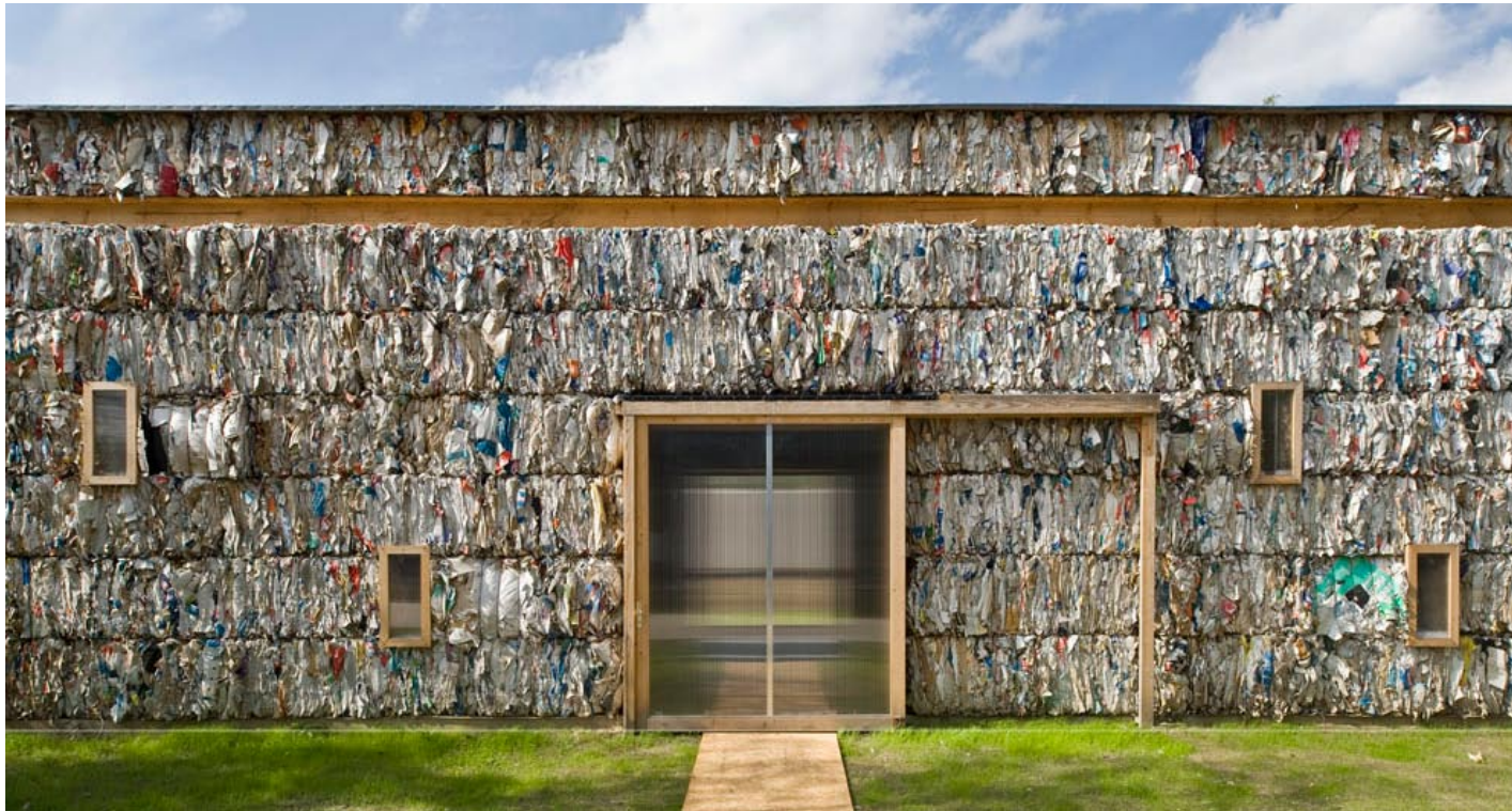
Dratz&Dratz: Haus PHZ2 – „mobile office Workspace“ auf Zeche Zollverein (Foto: Tomas Riehle )
