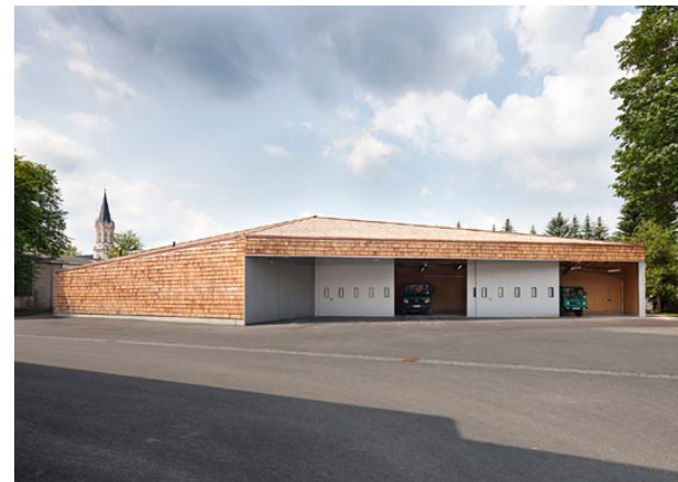
atelier st: Neubau eines Wirtschaftsgebäude für das Forstamt in Eibenstock (2007-10)
