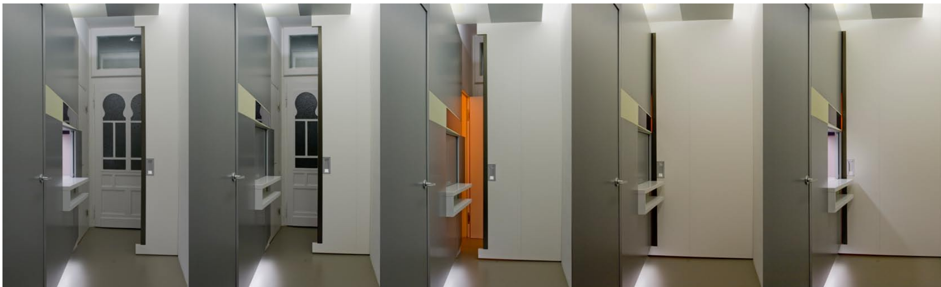
Eine Schiebewand trennt in dieser umgebauten Kölner Altbauwohnung den Flur von der Eingangstür. Die Durchreiche und das dunkle „Commander-Fenster“ darüber verbinden den Flur dann mit der Küche.
