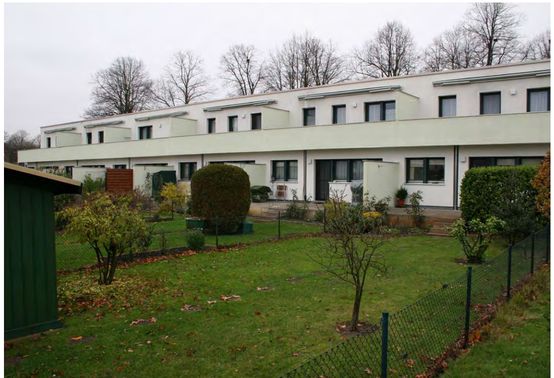
Der Lungenflügel mit Liegeterrassen ist das einzige Überbleibsel der Siedlung Blumlägerfeld. (Bild: Dietrich Klatt)
