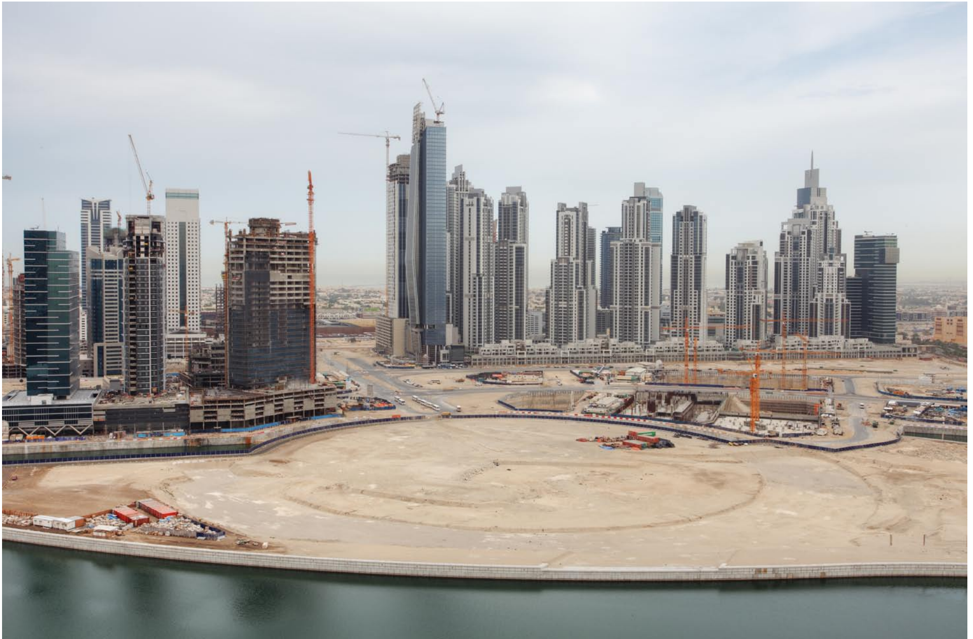
Im Bildvordergrund erkennt man das kreisrunde Bau­feld der Dancing Towers, der zentralen, über 400 Meter hohen Figur aus drei Türmen von Zaha Hadid. Ob sie jemals gebaut werden, ist fraglich.
