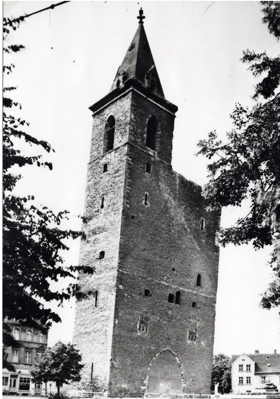
Nach dem Absacken war Staßfurts „Schiefe Kirche“ ein beliebtes Fotomotiv, konnte aber nicht dauerhaft gesichert werden und wurde 1964 abgerissen. (Foto: Stadtarchiv Staßfurt)
