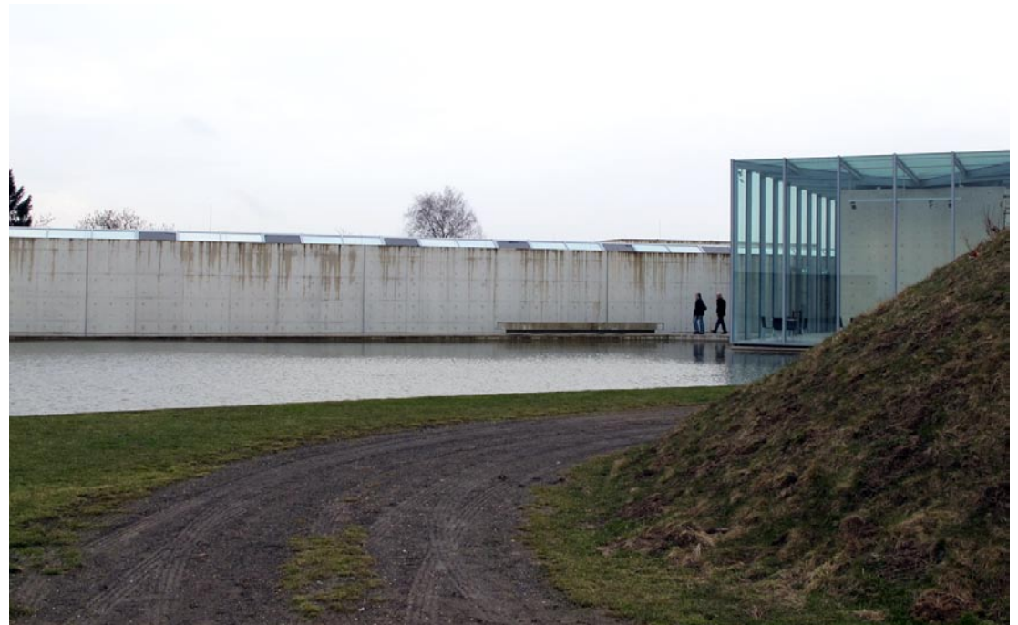
Blick auf den Eingang der Langen Foundation
