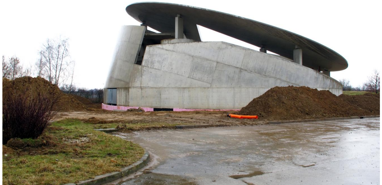
Das „Haus der Musiker“ von Raimund Abraham im Rohbau
