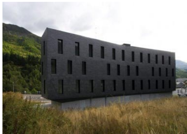
Wohnungsbau in Cerredo
