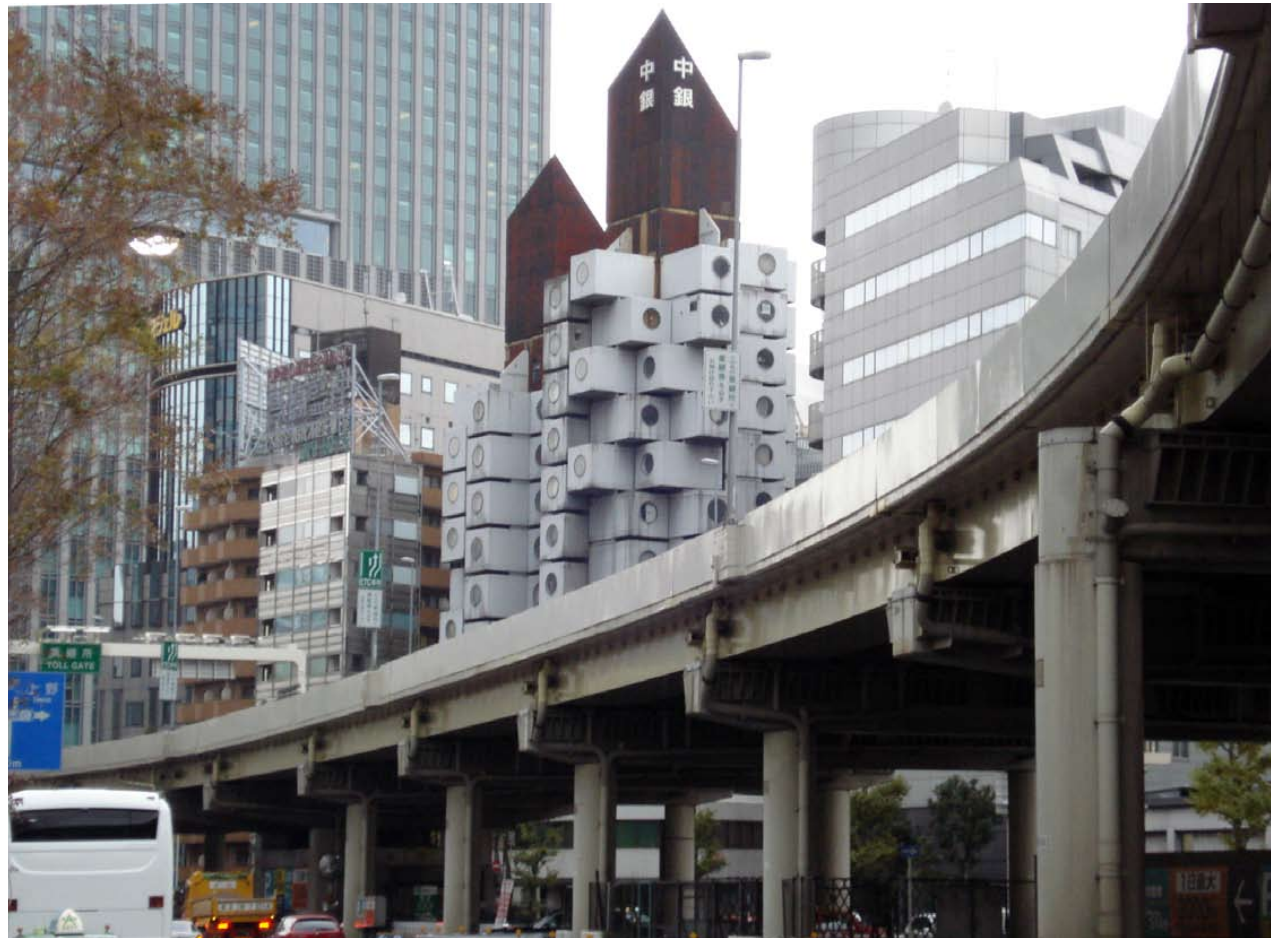
Hochstraße mit Kapselhäusern von Kisho Kurokawa
