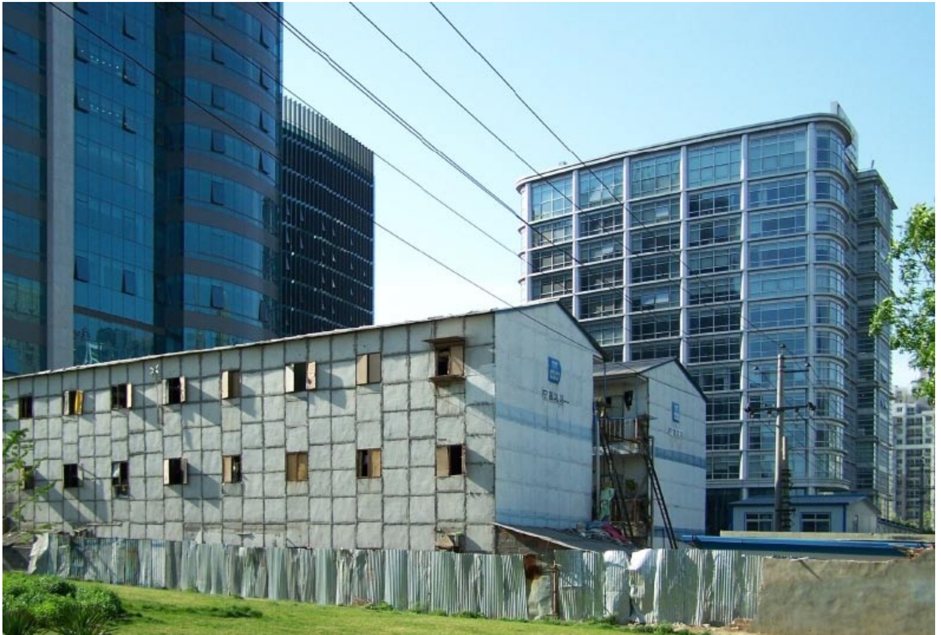
Wohnbaracke für Billiglohn-Bauarbeiter vor neuen Büro-Glaspalästen nahe Chao Yang Men im Osten Pekings
