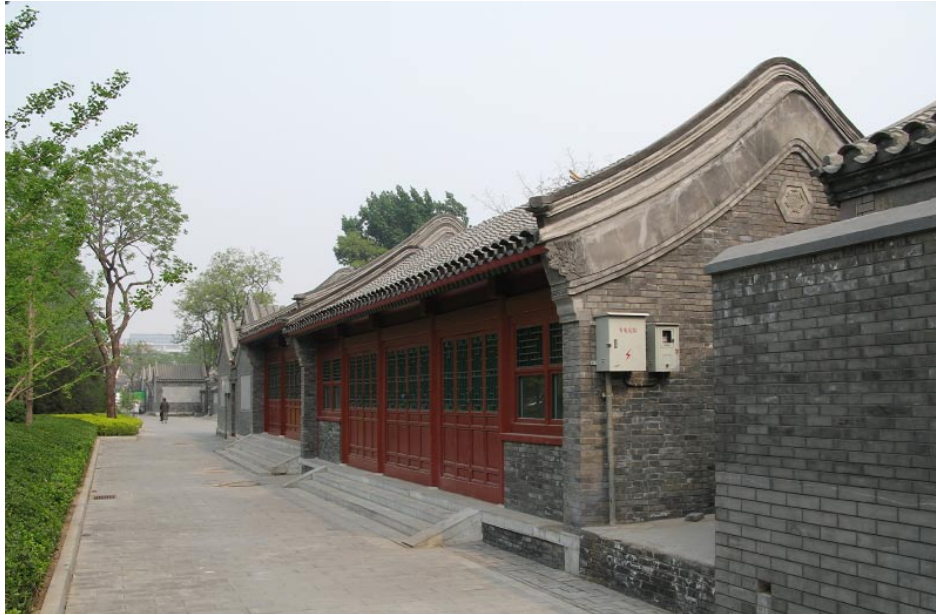
Erste sanierte Hutong-Häuser im Zentrum
