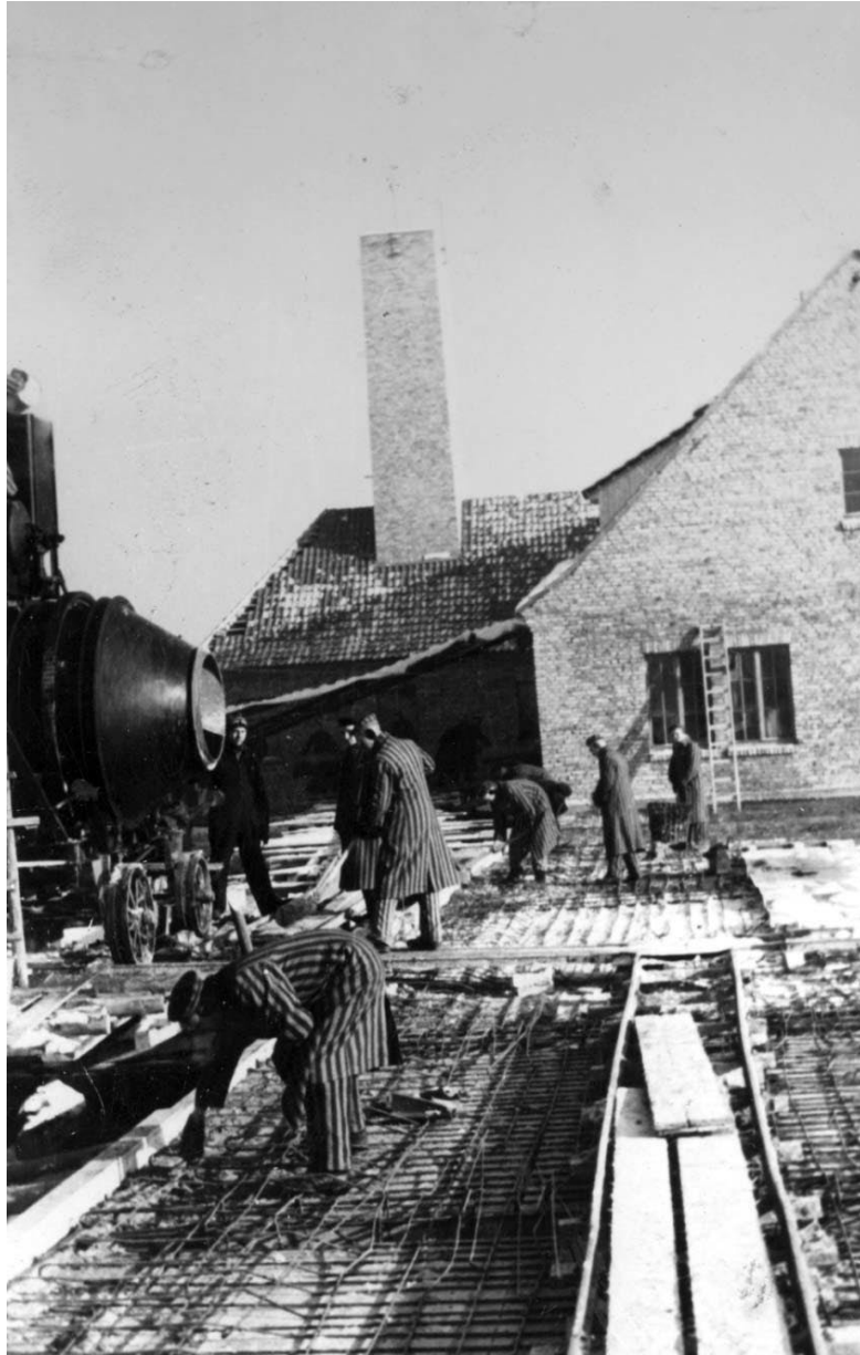
links: Im Frühjahr 1943 gießen Häftlinge eine Bodenplatte über den Umkleideräumen und Gaskammern, die sich im Untergeschoss der Krematoriengebäude befinden.
