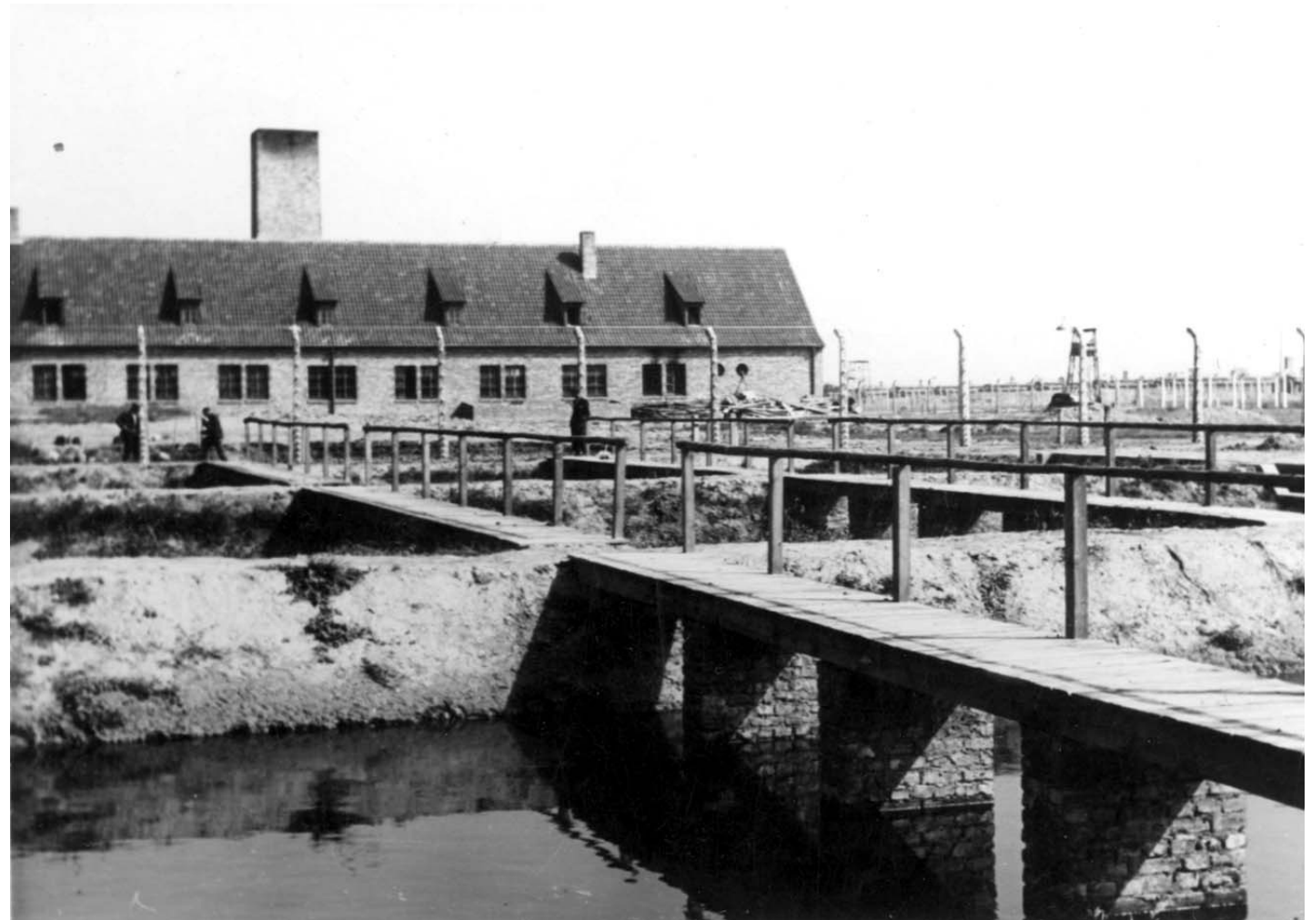
Das Krematoriengebäude II in Birkenau 1943 von Süden fotografiert. Der Ruß an den Schornsteinen deutet daraufhin, dass die Anlagen schon in Betrieb waren.
