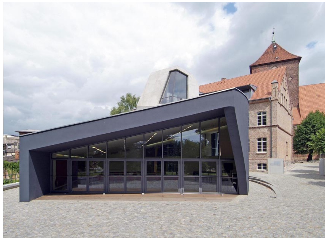
Museum und Vereinshaus Grevesmühlen, 2005. Das Schulgebäude von 1855 steht unter Denkmalschutz, sollte aber einen Anbau mit Veranstaltungssaal und eine barrierefreie Erschließung bekommen. Roland Schulz fügte beides auf der Rückseite an, die Materialsprache aus Sichtbeton und dunkelgrau verputztem Mauerwerk setzt sich deutlich vom Bestand ab.
