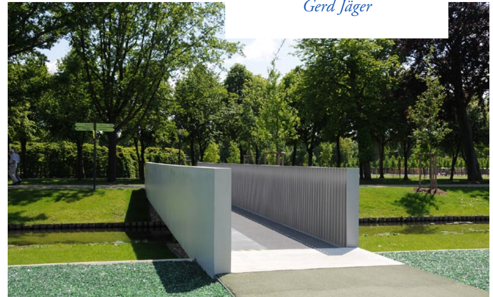
Drei Brücken aus weißem Sichtbeton für Fußgänger und Radfahrer auf dem BUGA-Gelände in Schwerin, 2009. Untergehängte Leuchten lassen nachts einen schwebenden Eindruck entstehen, die Brücken sollen den „minimalen Eingriff“ in die Parklandschaft symbolisieren.
