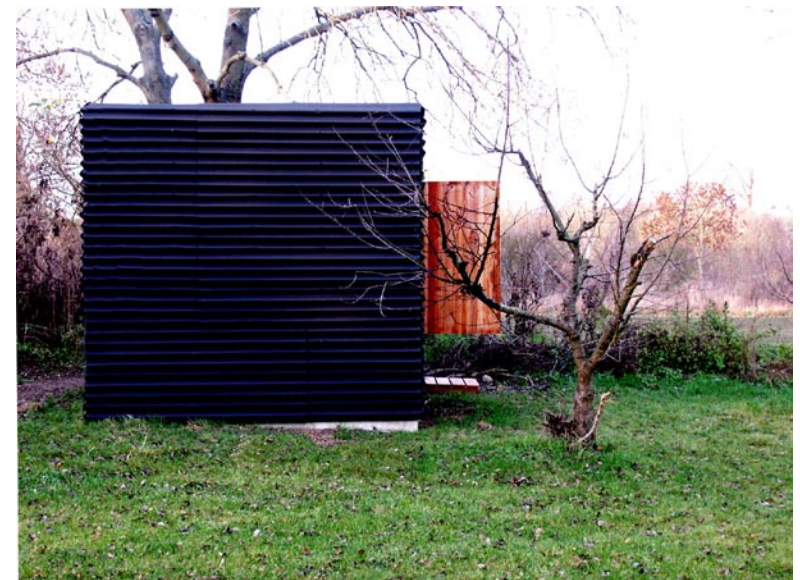
Sauna in Falkenhagen, 2007. Neun Quadratmeter, die als Arbeitsraum für Peter Grundmann, als Schlafraum oder als Sauna genutzt werden. Die Dämmung ist so stark, dass die Abwärme eines Computers und einer Lampe als Heizung ausreichen – nur für die Sauna muss zusätzlich geheizt werden.
