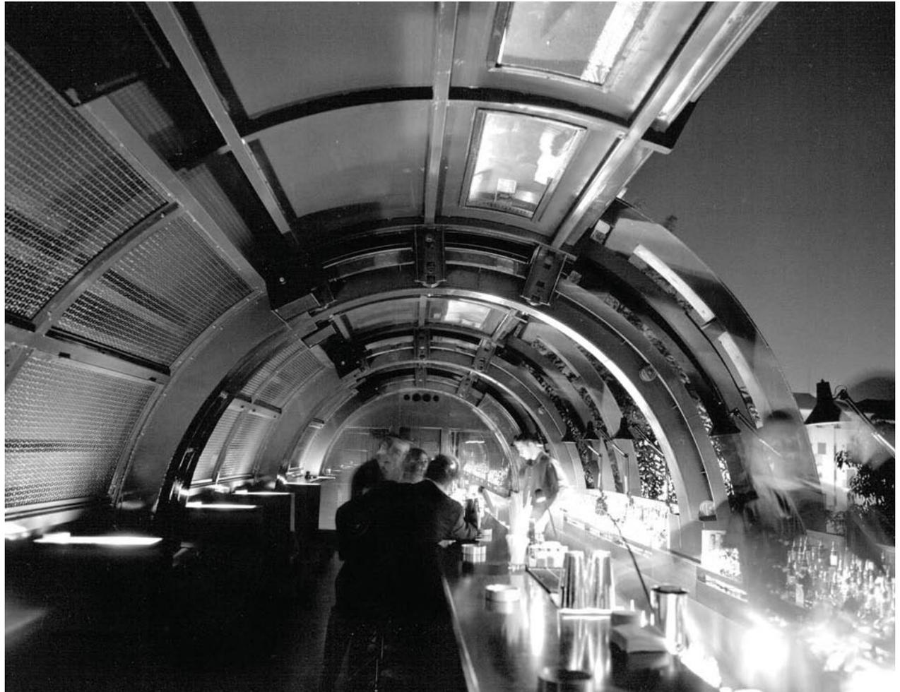
*Das Restaurant Centrale, ein Projekt von 2001, befindet sich in einem ehemaligen, natürlich auch im Krieg stark zerstörten Wohngebäude aus den 1920ern. Das Haus wurde entkernt und über der 17 Meter langen Bar mit einer Dachkonstruktion versehen, die sich nachts öffnen lässt.*
