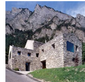
2005: Wohnhaus in Chamoson > Beton
