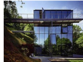
2000: Haus R 128 in Stuttgart > Sicherheitstechnik
