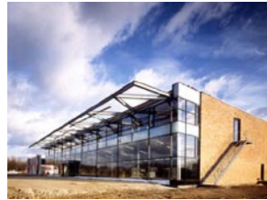
1999: Verkaufslager in Düren > Mauerwerk
