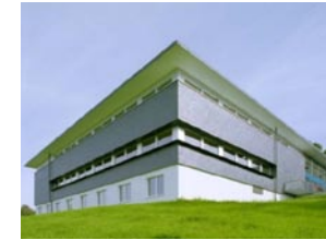
2001: Mehrzweckgebäude der Kantonsschule Trogen > Schiefer
