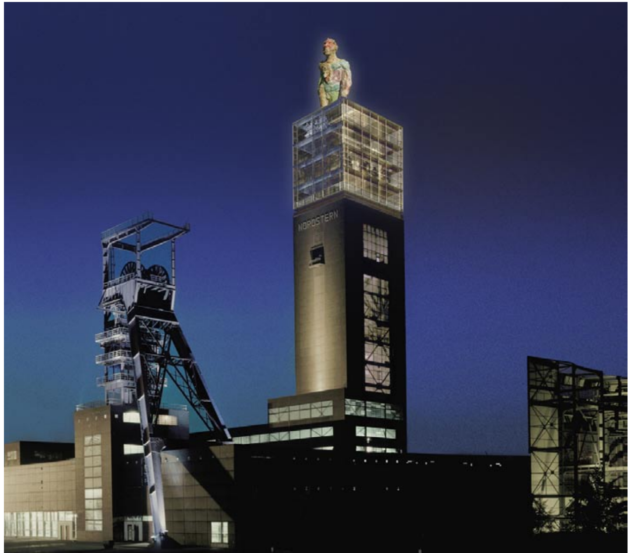
Links: Tetraeder in Bottrop Rechts: Aufstockung des denkmalgeschützten Schacht 2 der ehemaligen Zeche Nordstern in Gelsenkirchen
