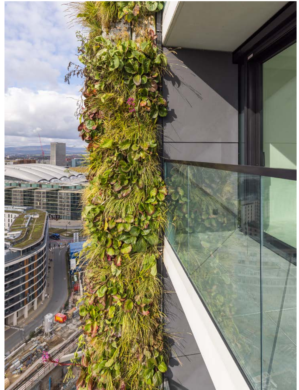
Fassade des Wohnhochhaus Eden (Magnus Kaminiarz) im Frankfurter Europa-Viertel. © Dennis Neuschaefer-Rube / Equitone
