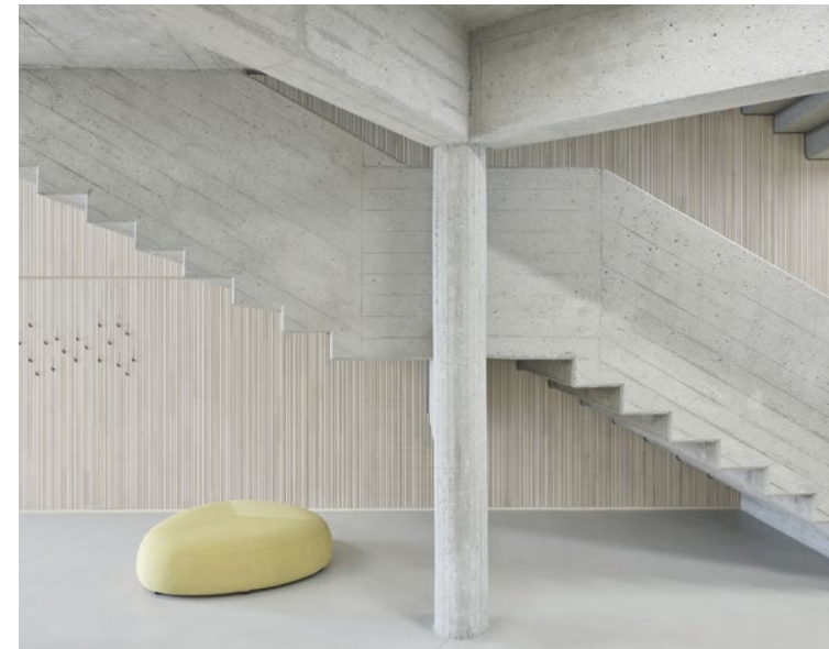
Schulgebäude in der Falkstraße Innsbruck, ausgezeichnet mit dem Tiroler Landespreis für Neues Bauen 2020
