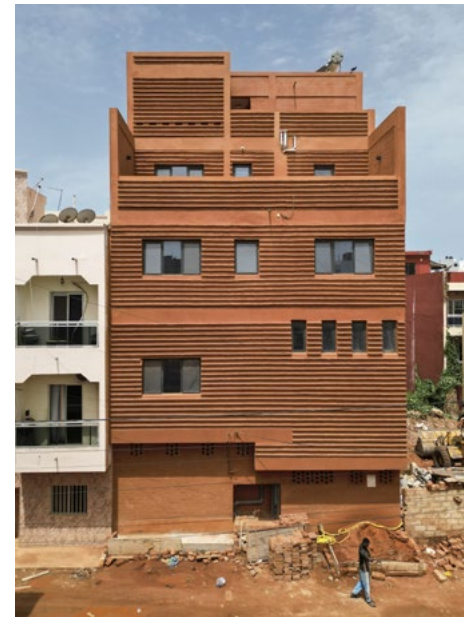
Das 4-geschossige Wohnhaus für eine Familie in Dakar wurde 2021 mit Steinen aus lokaler Erde gebaut und zum Teil mit Typha-Blöcken gedämmt. Die Steine werden nicht gebrannt. Fotos: Worofila
