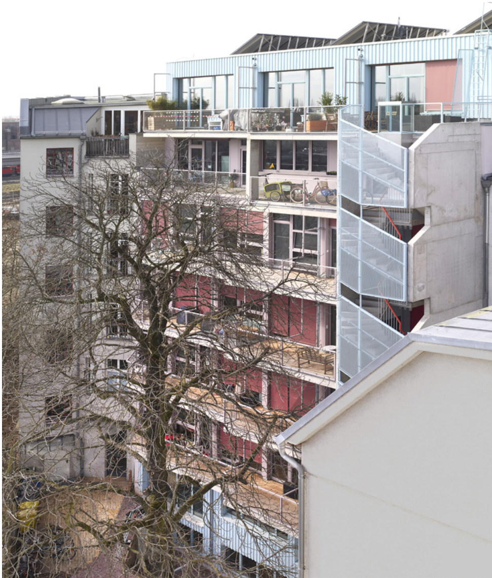
Vielfältiges, intergeneracionales Leben über die Geschosse hinweg im Lebensort Vielfalt am Ostkreuz (Berlin, 2019) von Christoph Wagner Architekten in Zusammenarbeit mit Wenke Schladitz. Foto: Erik Tschernow
