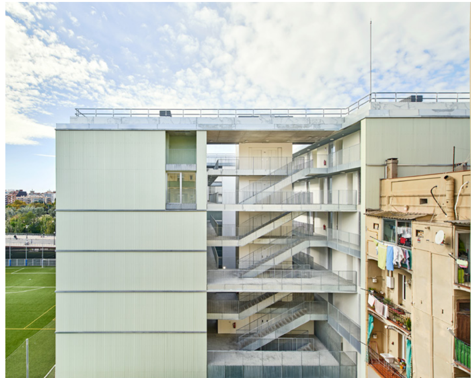
Offenes Treppenhaus mit Verbindung zur Nachbarschaft und Loggien mit Ausblick auf das Fußballfeld: Das Projekt Alí Bei (Barcelona, 2021) von Pau Vidal, Vivas Arquitectos und Arquitectura Produccions. Fotos: José Hevia
