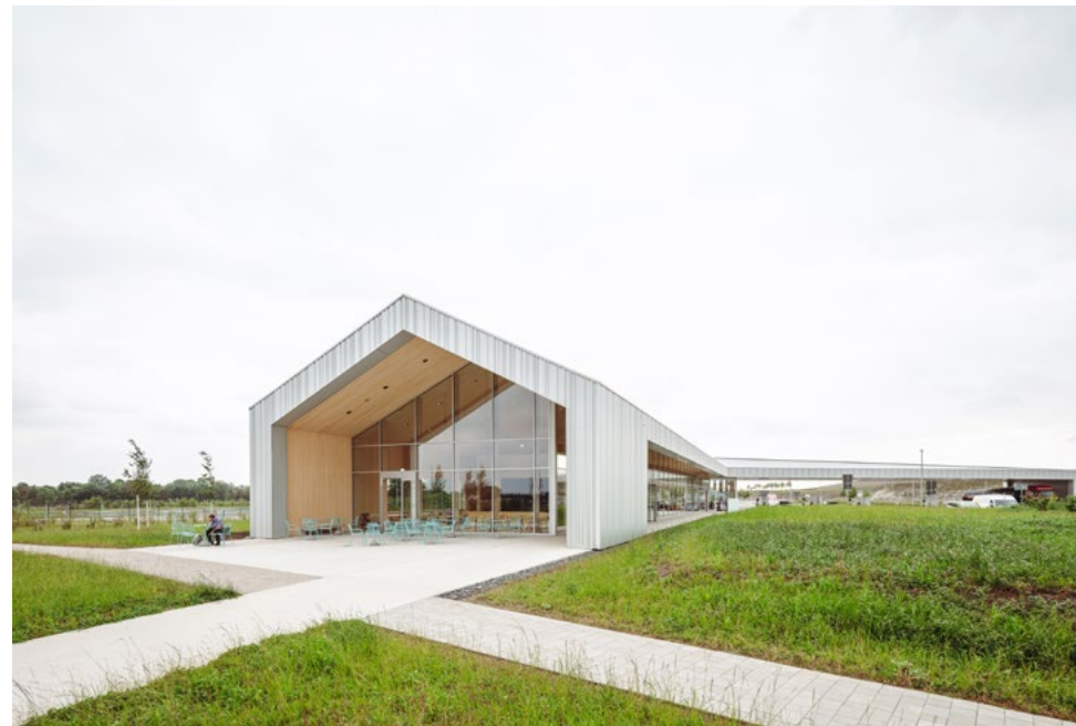
Endlich mal eine gute gestaltete Tank- und Rastanlage. Der Zwischenstop auf der A 71 am Leubinger Fürstenhügel lohnt aber noch aus einem weiteren Grund. Fotos: Thomas Müller
