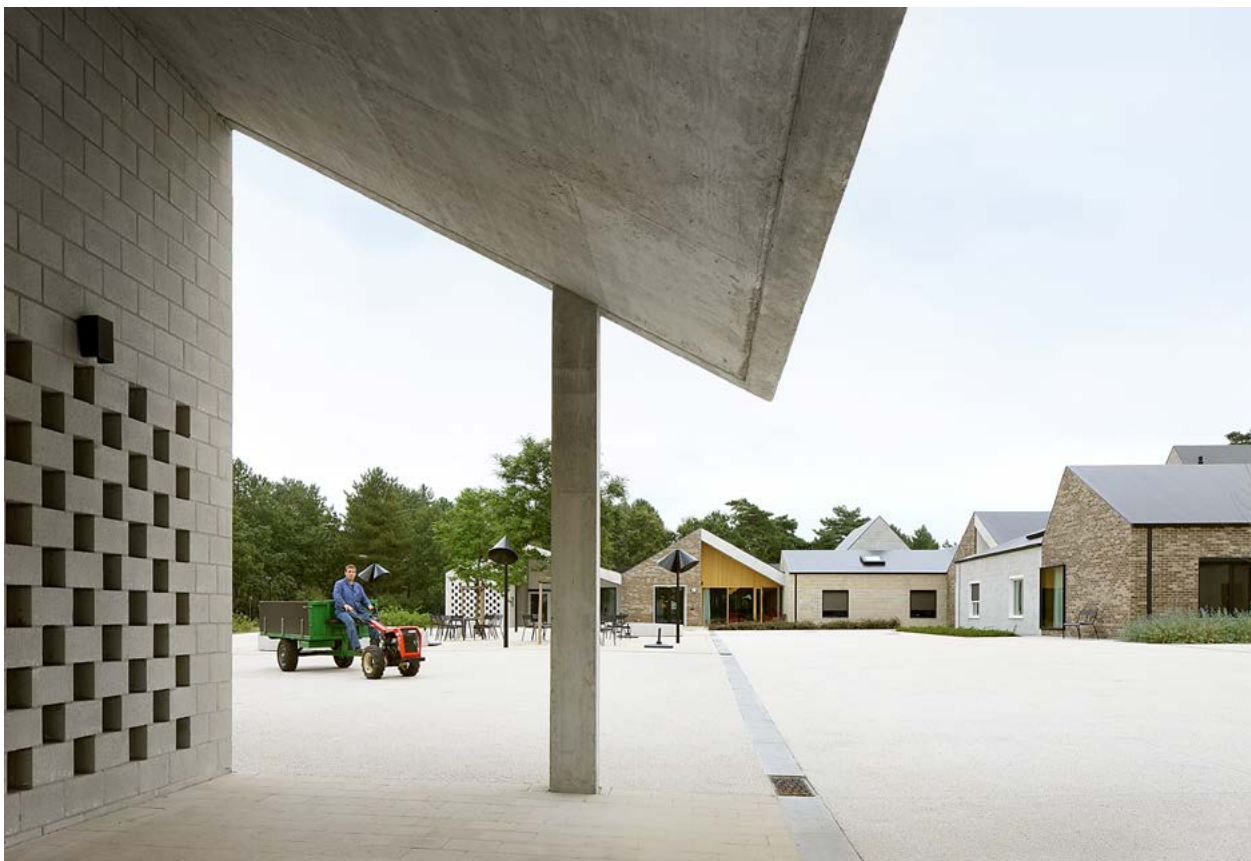
Der Wohn-Campus „Het GielseBos“ für schwer beeinträchtigte Menschen in Gierle (Entwurf: dierendonckblancke architecten) ist wie ein kleines, barrierefreies Dorf um einen zentralen Platz gestaltet. Foto: Filip Dujardin
