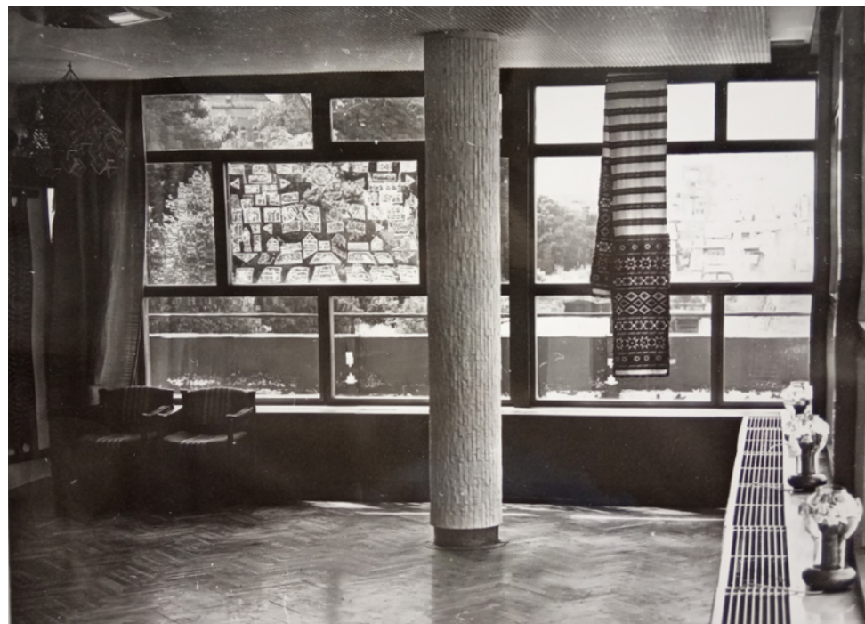
Fensterecke im Speisesaal kurz vor Fertigstellung, 1977. Fotograf unbekannt. Archiv Stelmashonok
