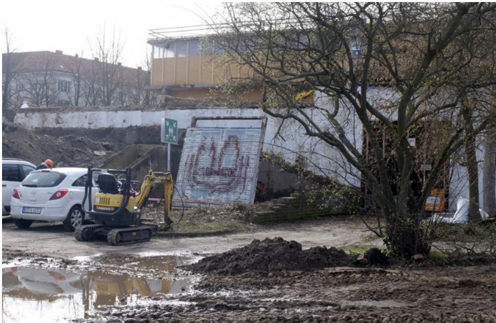
Das demontierte Signet des ehem. Restaurants vor der Baustelle des neuen Kunsthuses. Foto: Autorin, 2020
