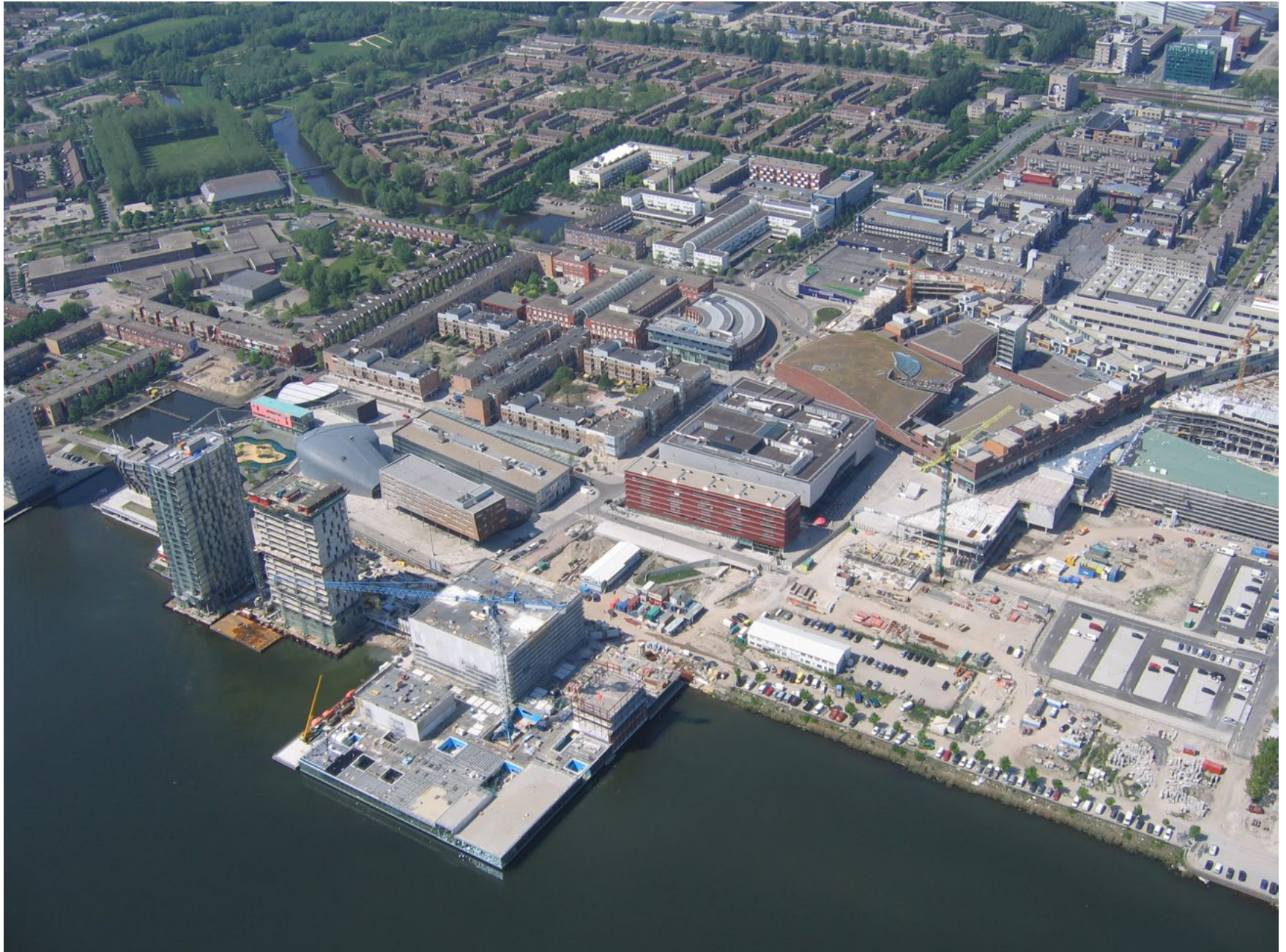
Das Stadtzentrum im Bau: Vorne in der Mitte „De Kunst- linie“ von Sanaa, links davon die Doppeltürme von Frits van Dongen, dahinter die drei Bauten von Will Alsop. Foto: OMA
