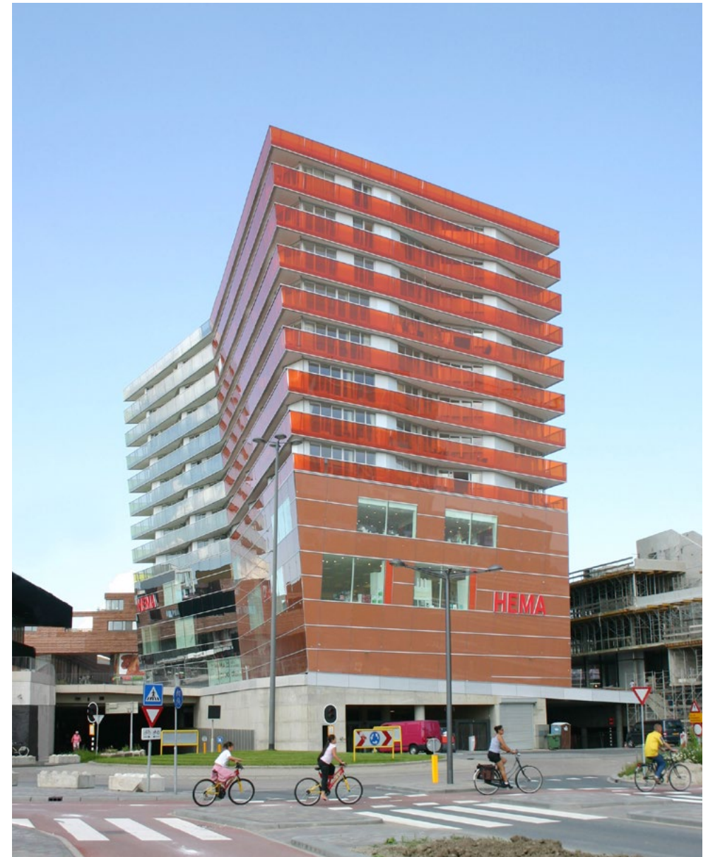
„De Smaragd“ von Gigon Guyer Architekten steht am östlichen Rand des von OMA konzipierten Stadtzentrums. Im Sockelbereich des Hauses liegen Einfahrten in die beiden Straßenspuren, die auf der untersten Ebene in West-Ost-Richtung durch das Stadtzentrum führen. Foto: Gigon Guyer
