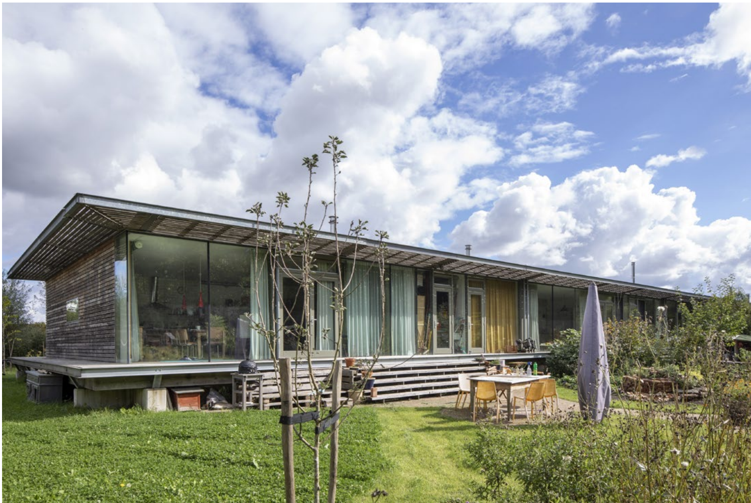
Coliving-Haus in Oosterwold von bureau SLA und ZakenMaker. Foto: Daria Scagliola
