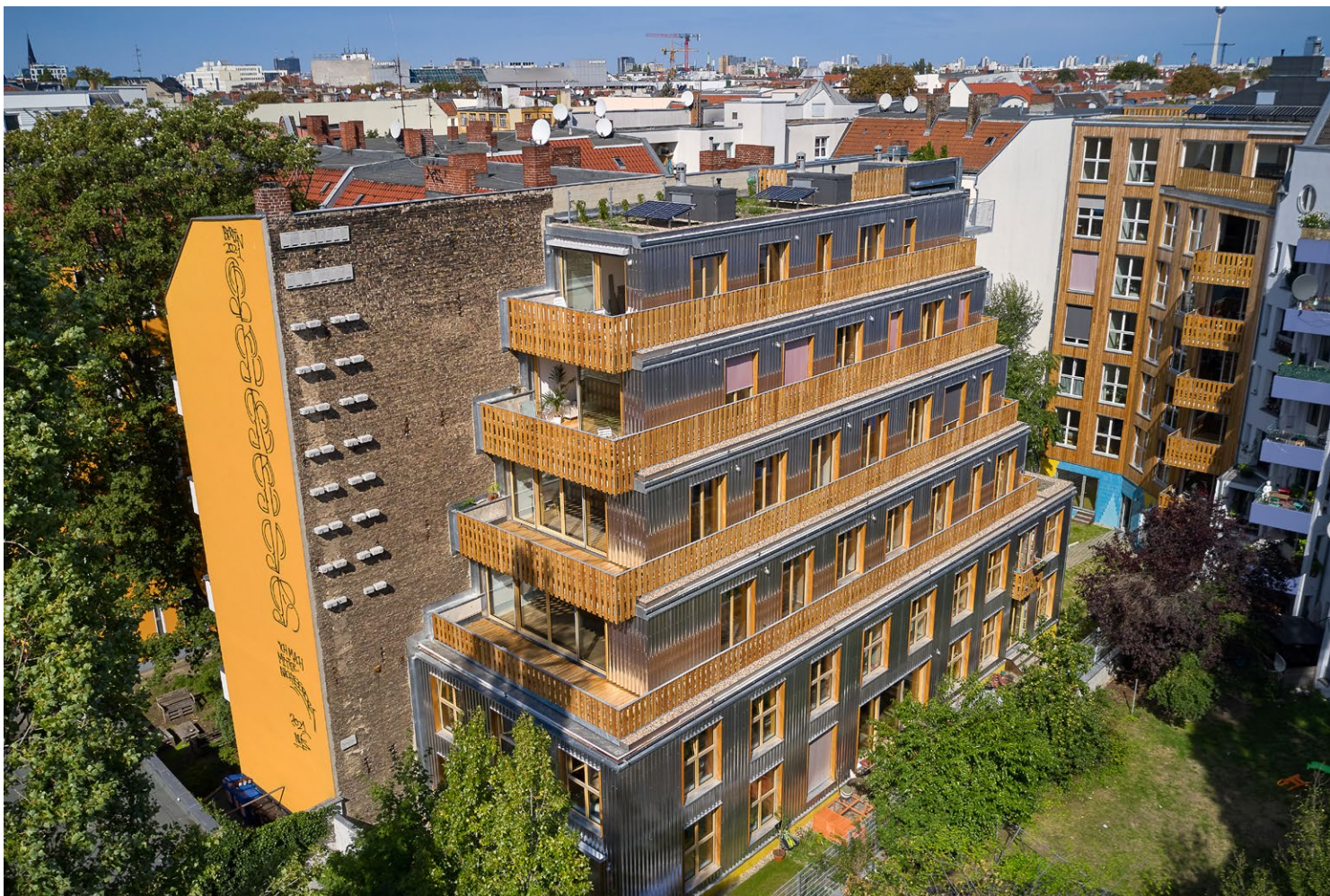
Baugruppe D2 in Berlin-Neukölln, Fertigstellung 2022, Foto: Thomas Straub
