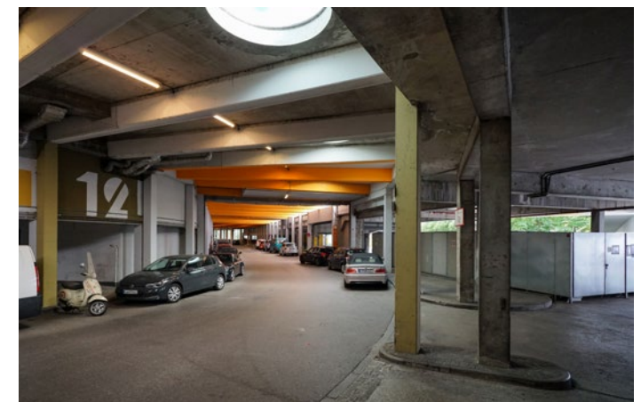
Seit der Sanierung wirken die unterirdischen Erschließungsstraßen wieder viel freundlicher
