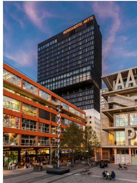
Oben links: Auf dem begrünten Dach des Werk3 lebt eine kleine Schafherde. Foto: Urkern/Ivana Bilz Oben rechts: John's Apartment im Werk12 wurde von allmannwappner gestaltet. Foto: Kim Fohmann Unten: Das schwarze Hotel (Werk4) wurde auf das ehemalige Kartoffelsilo gesetzt. Foto: Urkern/Ivana Bilz
