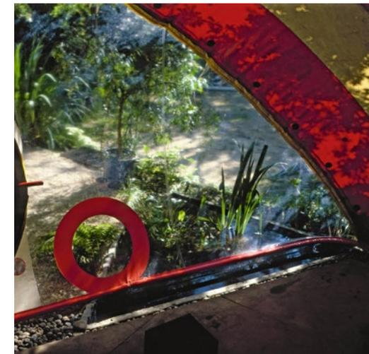
Der augenscheinlichste Unterschied zwischen aufblasbaren Volumen und traditionellen Bauweisen liegt darin, dass Erstere der Schwerkraft mit Leichtigkeit entgehen. Während eine Mauer aus Steinen ihre Stabilität durch die Addition der Gewichte erhält, begründet sich die Stabilität der Volumen auf dem Gesetz der allseitigen Druckausbreitung nach Blaise Pascal. Dieses besagt, dass der Eingangsdruck an
