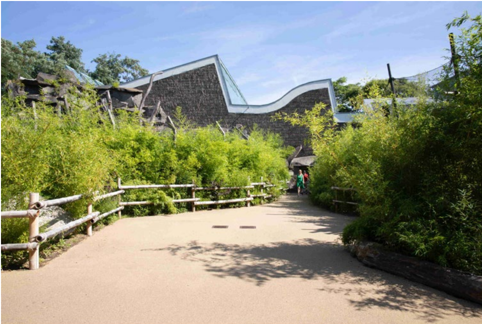
Von 2015 bis 2020 planten dan pearlman Erlebnisarchitektur das denkmalgeschützte Alfred-Brehm-Haus im Tierpark Berlin von Heinz Graffunder und dessen Außenanlagen um. Fotos: Tierpark Berlin / dan pearlman
