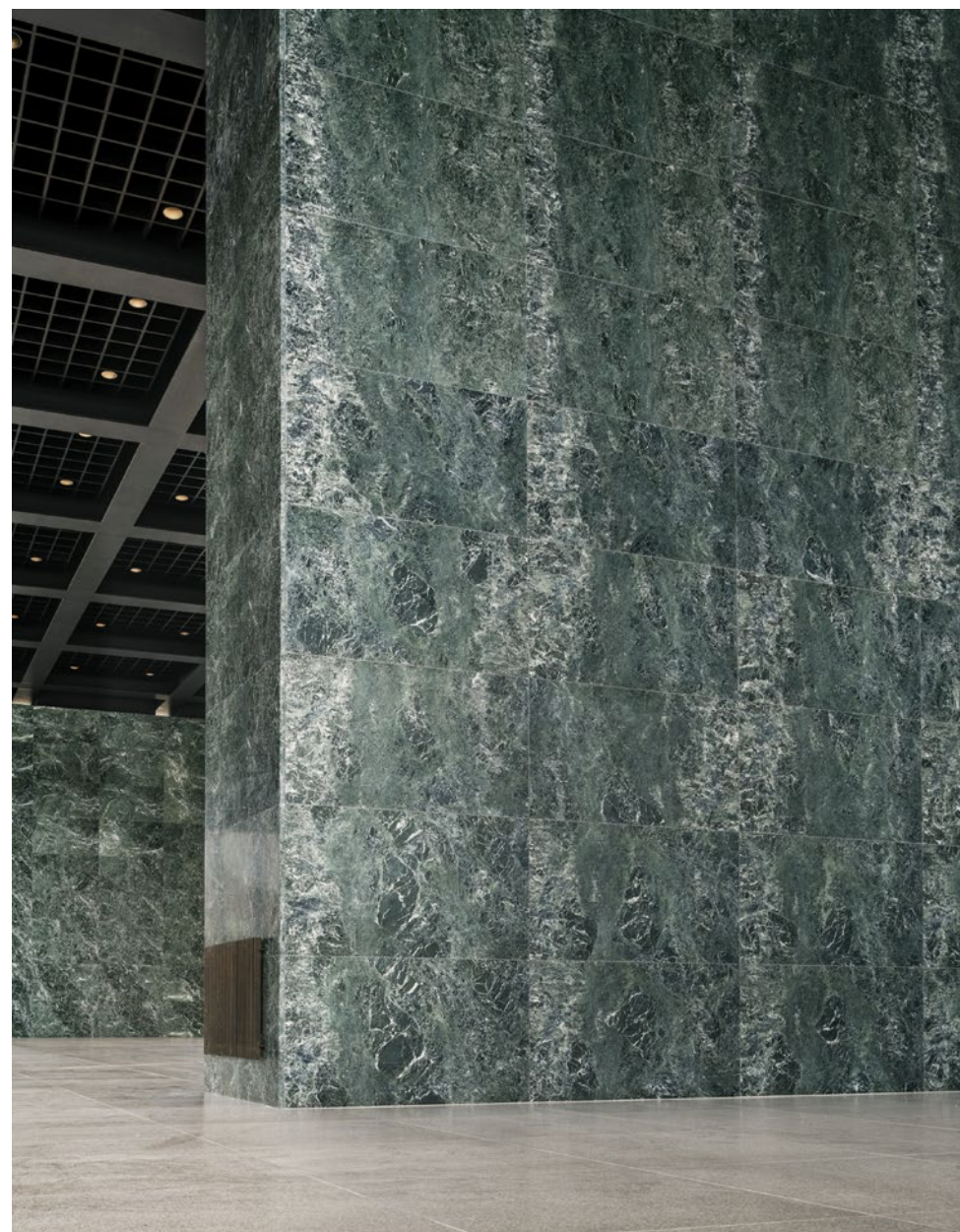
Abgenommen und wieder angehängt: Die mit grünem Tinos Marmor verkleideten Wandpfeiler in der Ausstellungshalle nach der Sanierung. © Simon Menges
