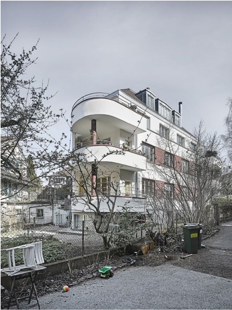
Links: Wohnhaus Schillingstraße 28 Rechts: Wohn- und Geschäftshaus Brünnenstraße 108-112 Fotos: Thomas Telley und Adrian Scheidegger
