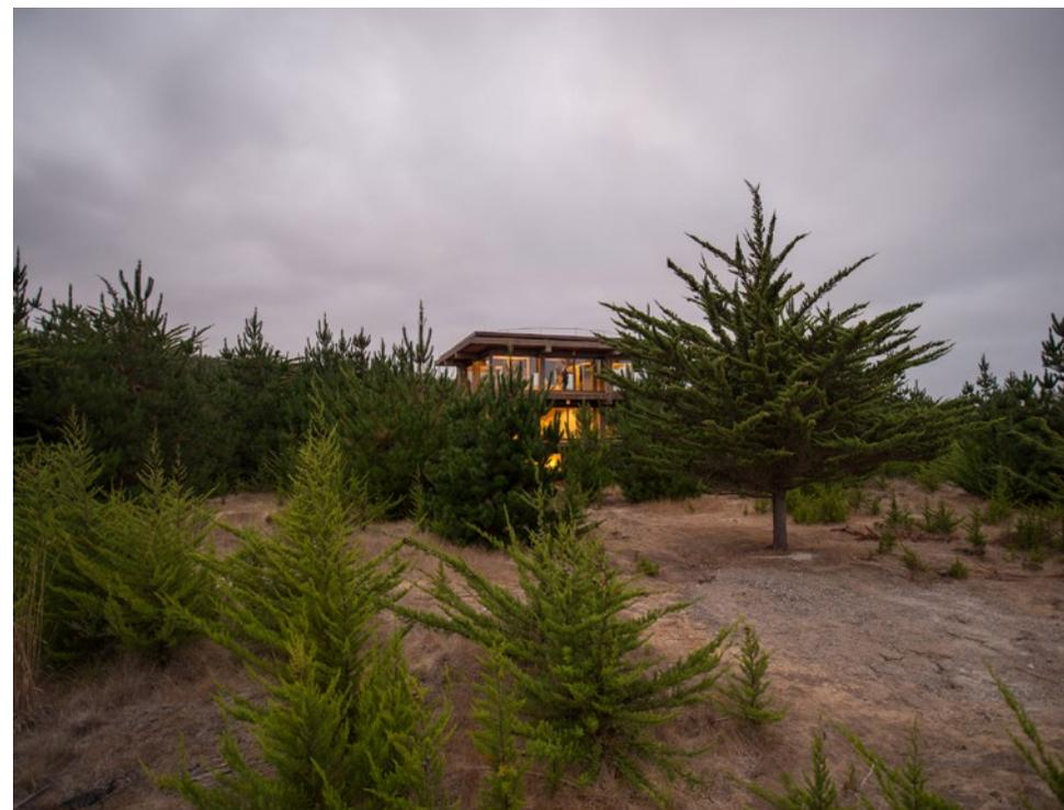
Das Achsmaß beträgt vier Meter, die Raumhöhe 2,70 Meter. Jede der drei Ebenen kragt um eine halbe Achse weiter aus, sodass eine kleine umgekehrte Stufenpyramide entsteht – auch wenn Pezo von Ellrichshausen betonen, dass ihnen solche Anleihen an uralte Typologien und Formen fremd seien. Dynamisch wird der Entwurf durch die außermittig platzierte Wendeltreppe, die durch das gesamte Haus bis auf die Dachterrasse führt.
