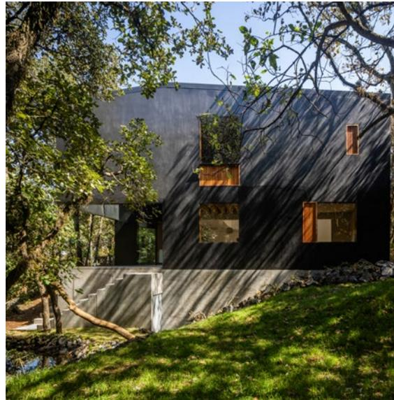
Dennoch ist es ein Neun-Quadrat-Raster-Haus, das Grundmaß beträgt 4,20x4,20 Meter. Betreten wird der Bau über eine Ecke, an der das Neuner-Raster geöffnet blieb. Die Tür ist dramatisch zwei-flügelig in die Ecke geschnitten. So entsteht – ähnlich wie bei Pezo von Ellrichhausens „Haus NIDA“ – eine Erschließungs-Diagonale: Auf der gegenüberliegenden Ecke befindet sich eine Terrasse mit doppelter Betontreppe zum Garten.
