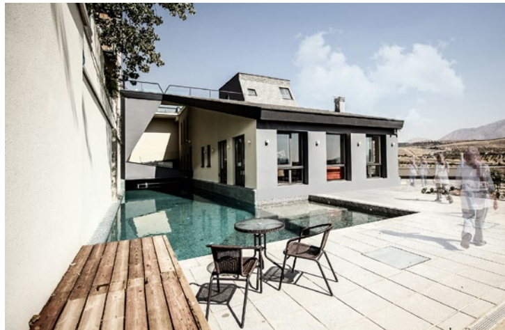
Die Fast Villa in Lavasan von L.E.D. heißt Fast Villa , weil ihre gesamte Grundkonstruktion in nur 17 Tagen errichtet wurde. Foto: Shahab Mirzaean
