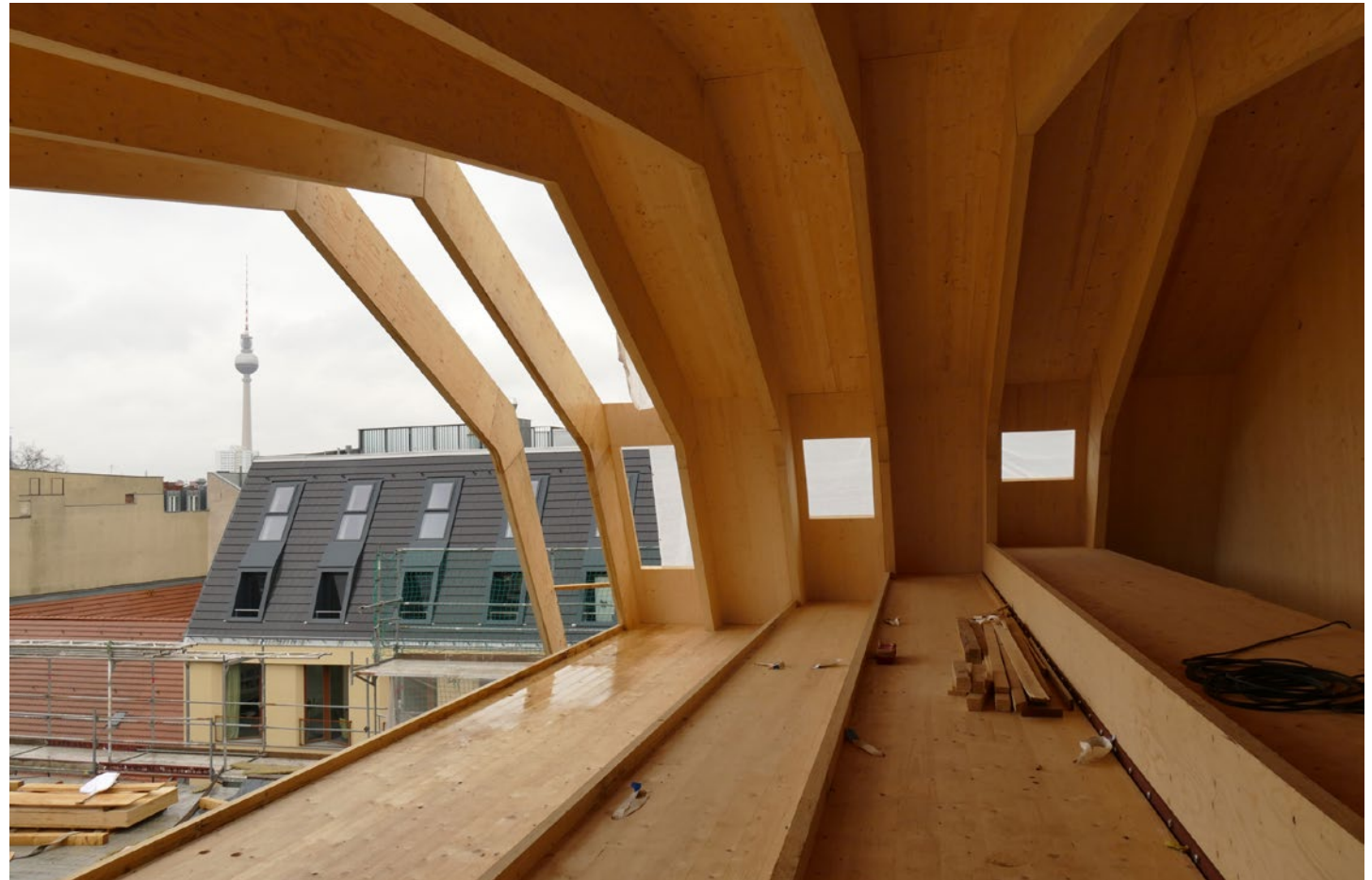
Auf der Baustelle der Metropolitan School, Fotos: Sauerbruch Hutton
