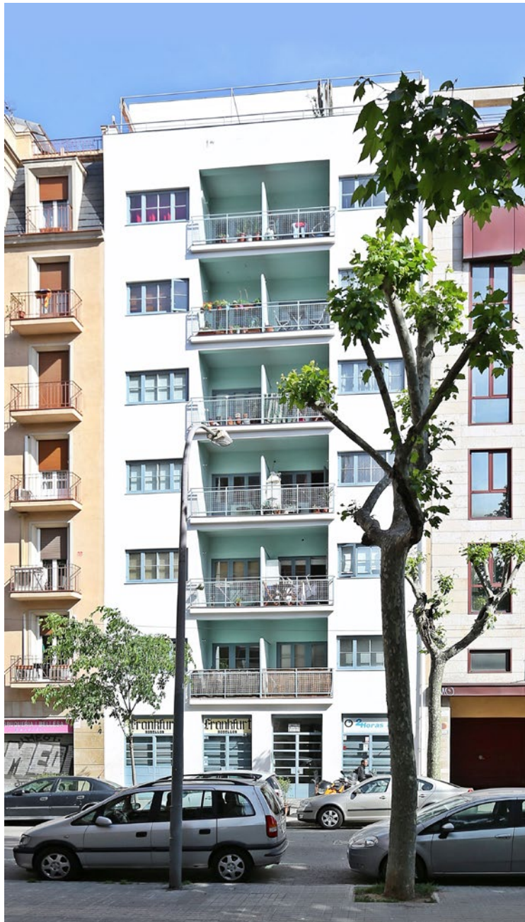
Wohnhaus in der Calle del Rossellón, das Josep Lluís Sert 1929 errichtete. Mit Gebäuden wie diesem konnte er sich als eine der treibenden Kräfte der jungen Avantgarde um die Gruppen GATEPAC und GATCPAC etablieren. Foto: Klaus Englert
