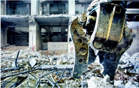
Das Kraftwerk beim Umbau, Foto: Stenger2
