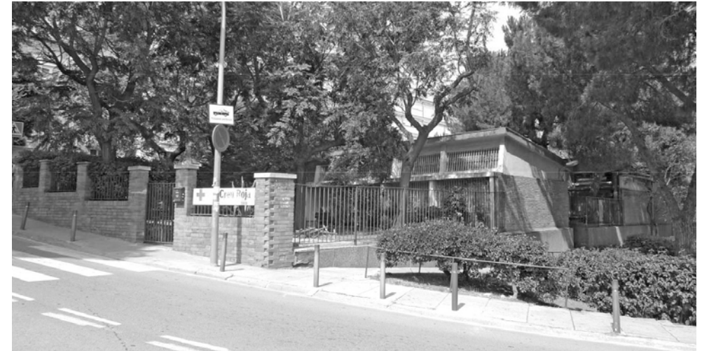
Nach mehreren Umbauten war die alte Schule vergittert und vernachlässigt. Dank des Umbaus von Oliveras Boix Arquitectes zeigt sich die Bibliothek jetzt offen und sortiert. Foto links: José Hevia
