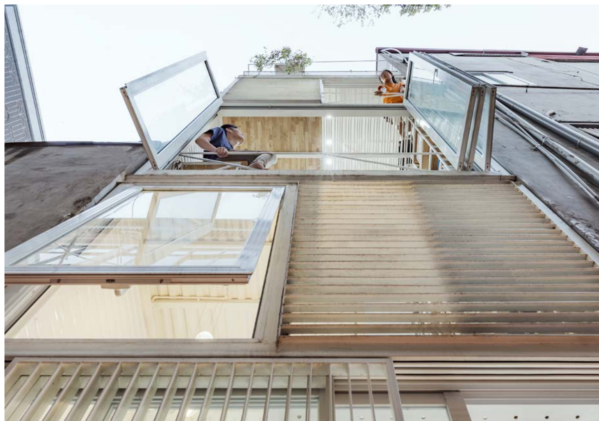
Kommunikation zwischen den Etagen: Das Büro von SMA hat kaum Grundfläche – die jungen Gestalter haben das Beste daraus gemacht, Foto: Nguyen Thai Thach
