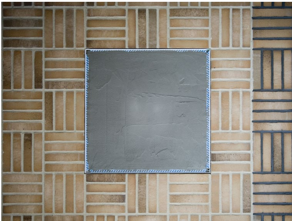
Rund 60 Prozent der Fassade aller Bauten in der WerkBundStadt sollen aus Backstein sein. Eine Wand im noch stehenden Werkbundhaus auf dem Gelände zeigt erste Studien für Verbund-Putz-Farb-Kombinationen
