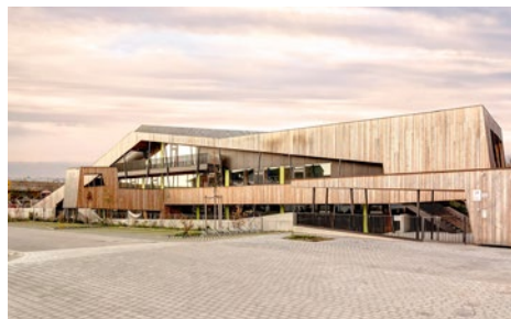
Montessori Kinderhaus in Erding, Foto: Jakob Kanzleiter
