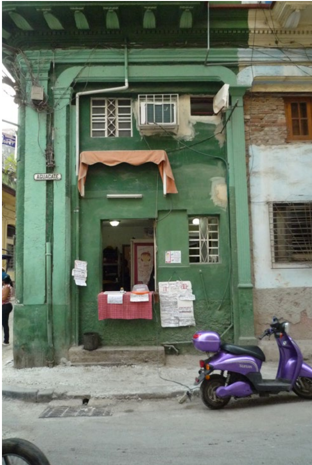
Je nach Bedarf und mit einfachsten Mitteln werden barbacoas und zusätzliche Fenster eingefügt. Die Struktur der Bauten ändert sich so, dass man den Originalzustand oft nicht mehr ausmachen kann. Fotos: Riccarda Cappeller
