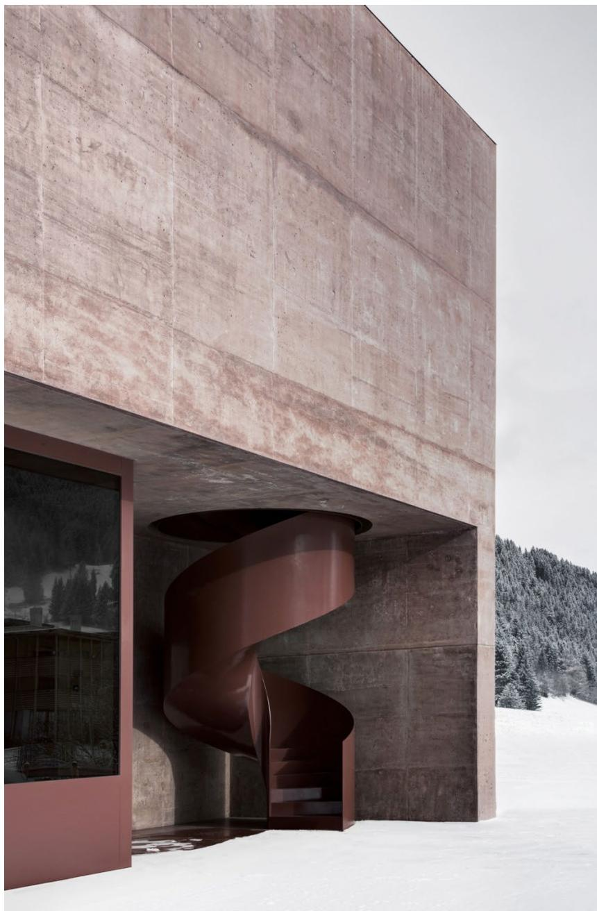
Mit ihrer Feuerwache in Vierschach zeigen die beiden Architektenbrüder Alexander und Armin von **Pedevilla Architects** (Bruneck), dass es bei der Verwendung von rotem Beton nicht immer um die Signalwirkung gehen muss. Aus Leichtbeton gegossen, sorgt die zarte Farbe der Fassade selbst im Winter für eine gewisse südliche Leichtigkeit. Das Gebäude konnte 2015 in Betrieb genommen werden, nachdem Pedevilla Architects 2011 den Wettbewerb gewonnen hatten. Foto: Gustav Willeit
