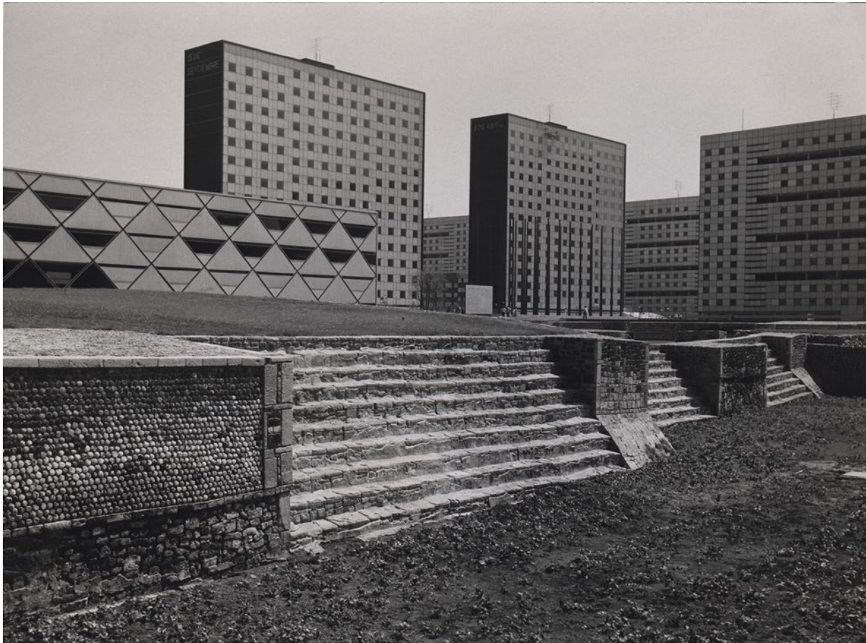
Die von Mario Pani Anfang der 1960er Jahre errichtete Großsiedlung Tlatelolco in Mexiko-Stadt wurde während des großen Erdbebens 1985 teilweise zerstört. Fotos: Mario Pani Archiv, Tecnológico de Monterrey
