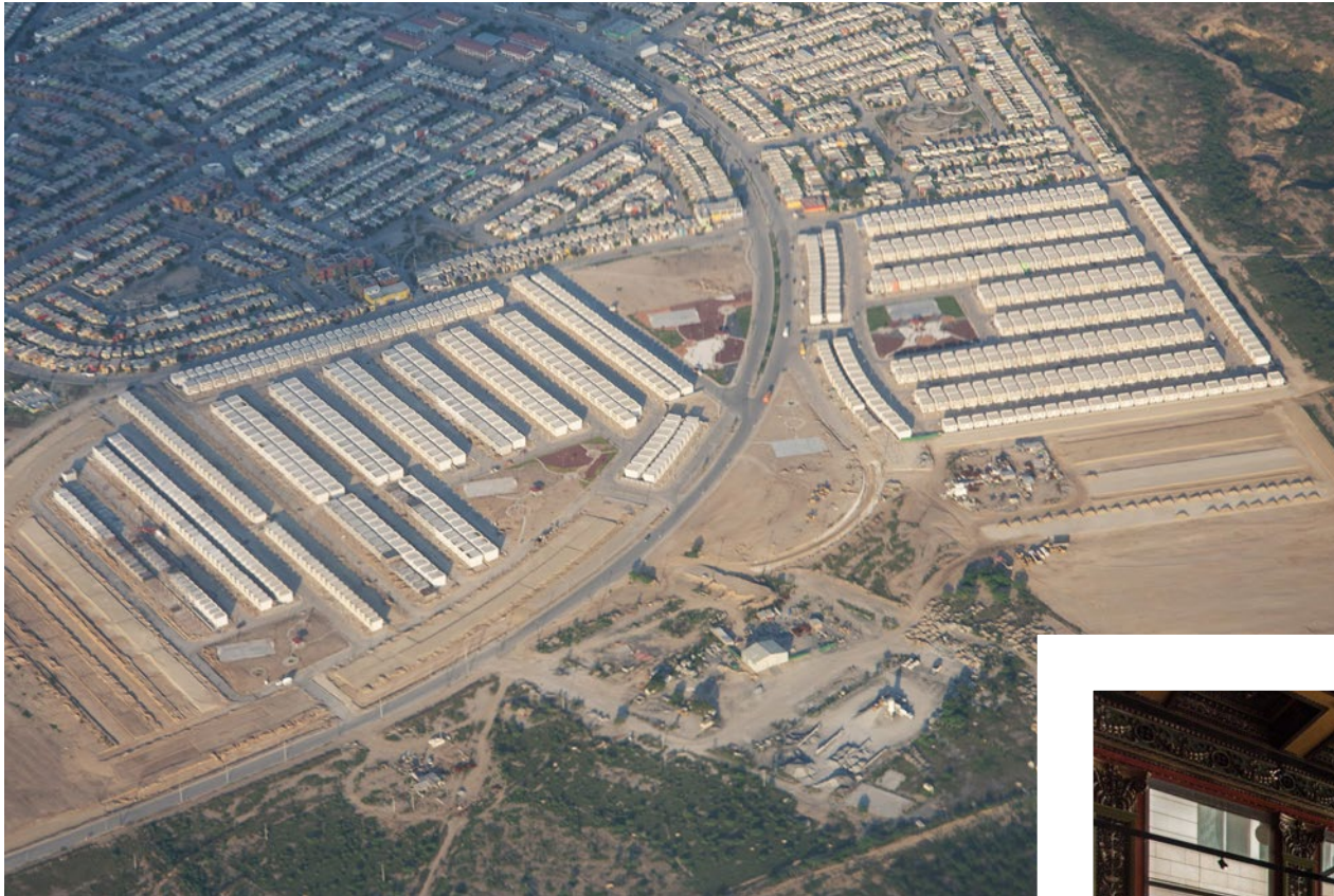
Monotone Rasterbauweise in Monterrey – viele der Millionen neugebauten Häuser stehen leer. Foto: Carsten Krohn
