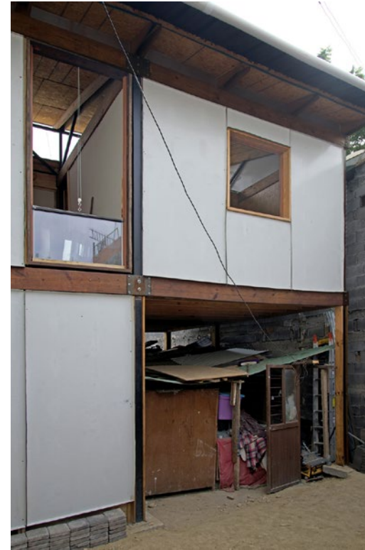
Links: Casa Rosienda, Rechts: Casa Viesca. Beide Projekte wurden von Impulso Urbano in Monterrey gebaut. Die aufgeständerte Bauweise ermöglicht, dass Bewohner während der Bauarbeiten in ihrem Zuhause auf dem Grundstück weiterleben können. Fotos: Carsten Krohn
