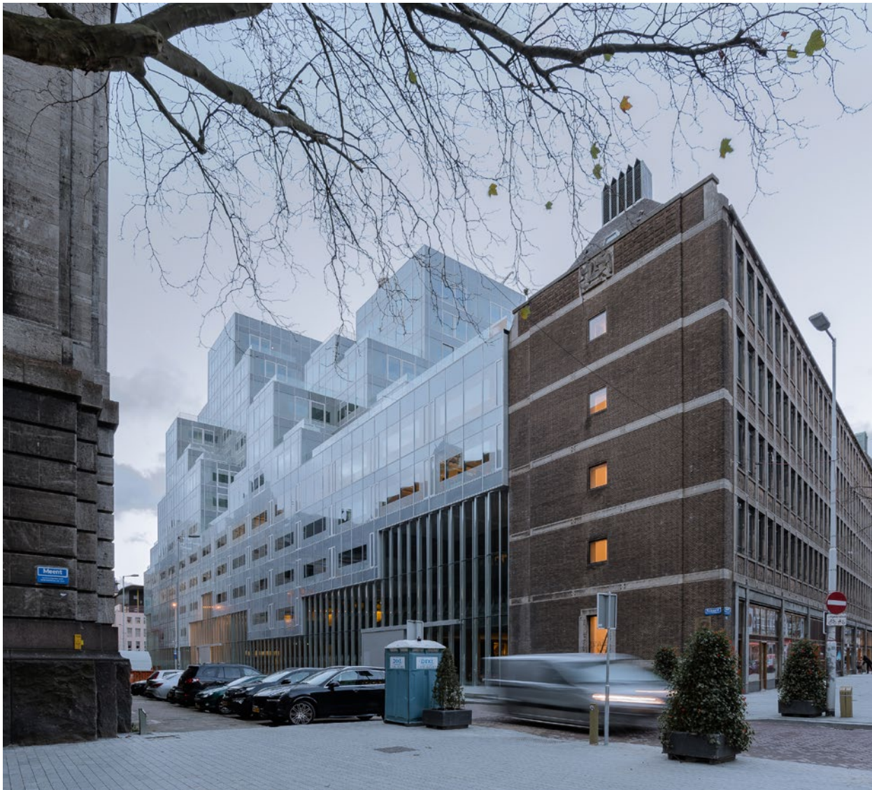
Wohn- und Bürokomplex Timmerhuis in Rotterdam von OMA, 2015, Foto: Sebastian van Damme
