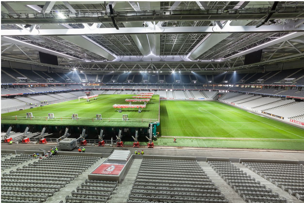
Stade Pierre Mauroy in Lille von Atelier Ferret Architectures und Valode et Pistre Architectes, Foto: Jérôme Pouille
