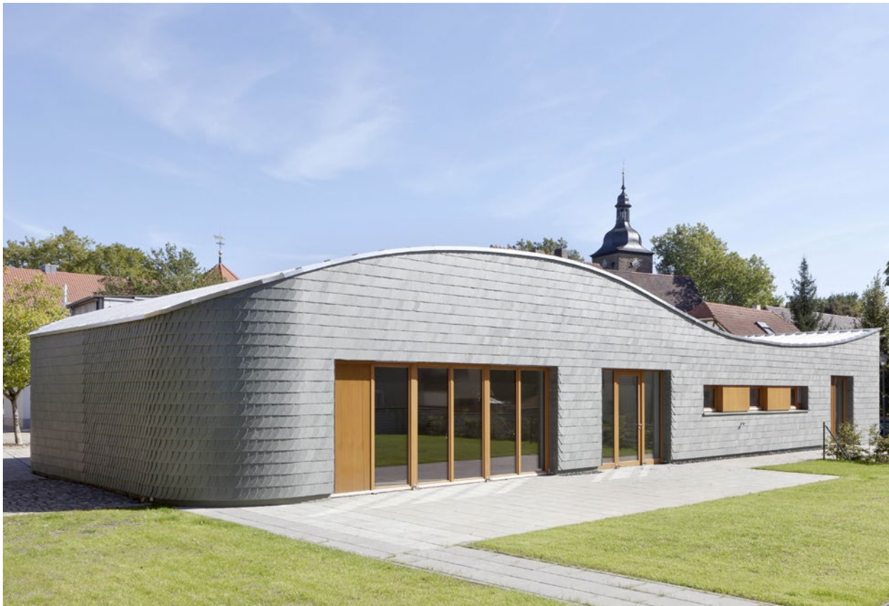
Das sanft geschwungene Dach zeichnet die Form eines Fisches nach, der Schiefer ist schuppenartig gedeckt, Fotos: Chris Saile
