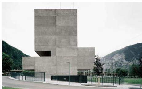
Kraftwerks-Leitstelle von Bechter Zaffignani in Silz Foto: Rasmus Norlander
