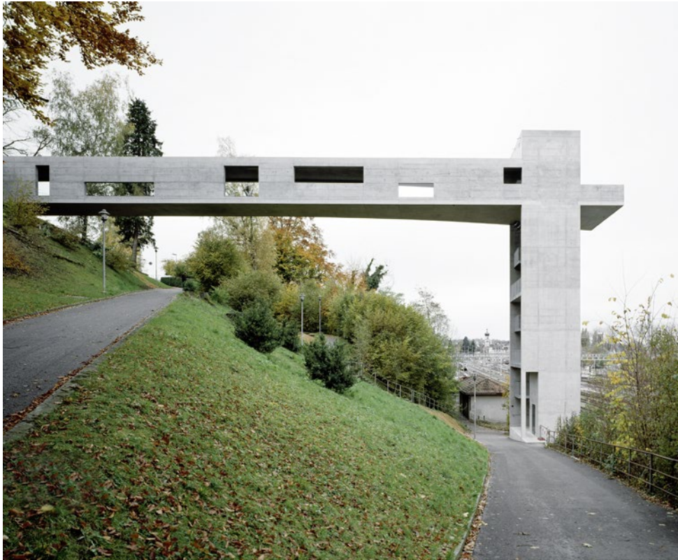
Lift- und Treppenturm in Rorschach von Buob Architekten, Fotos: Barbara Bühler
