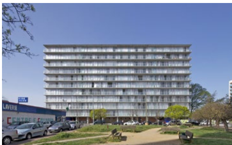
Bâtiment G im Quartier Grand Parc, Bordeaux, von Lacaton &amp; Vassal, Foto: Philippe Ruault
