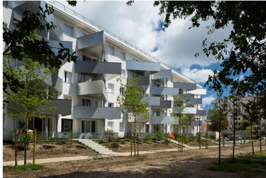
Unterschiedliche Balkone als Lösung gegen die Monotonie in der Siedlung Arago éco-quartier in Bordeaux nach der Transformation von Martin Duplantier Foto: Martin Duplantier Architectes
