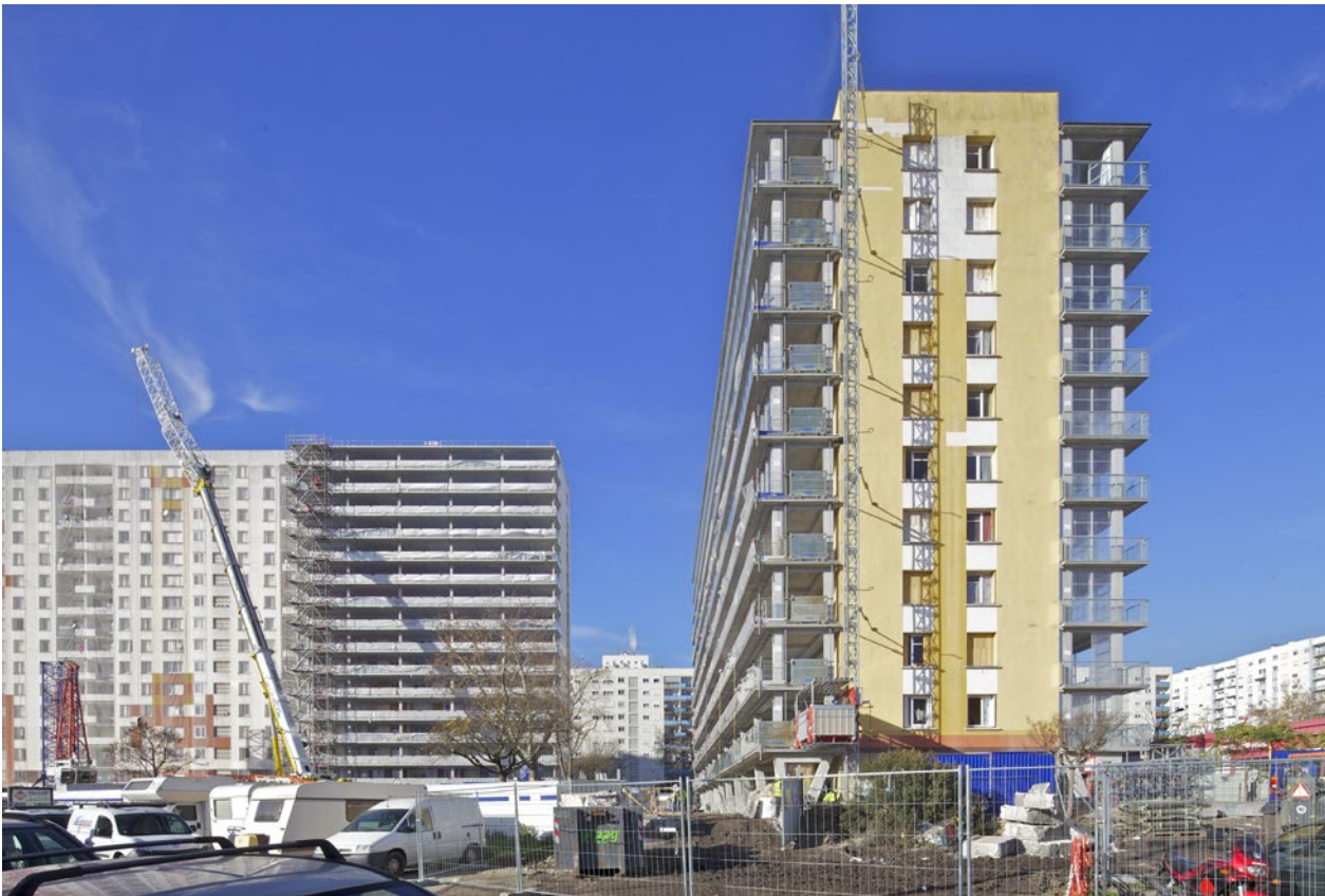
oben: Vor der Transformation der drei Bauten in der Großsiedlung du Grand Parc in Bordeaux, unten: Umbauarbeiten von Druot, Lacaton & Vassal und Hutin Fotos: Philippe Ruault
