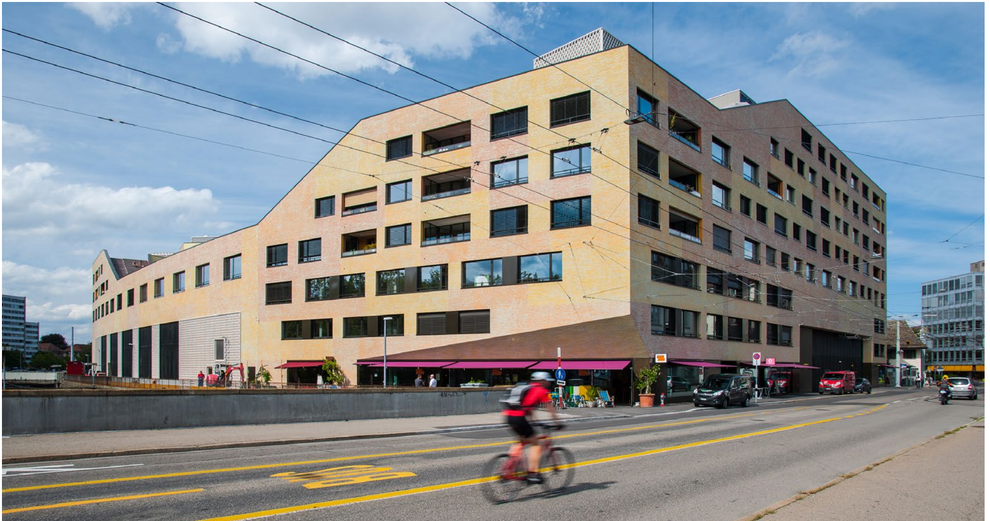
Von der Straße aus sieht man, dass das Gebäude das Straßenbahndepot integriert, Foto: Volker Schopp
