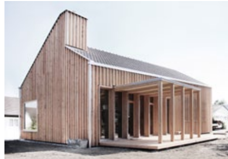
Neubau Wohnhaus, Egnach, Schweiz, Fotos: Katia Rudnicki
