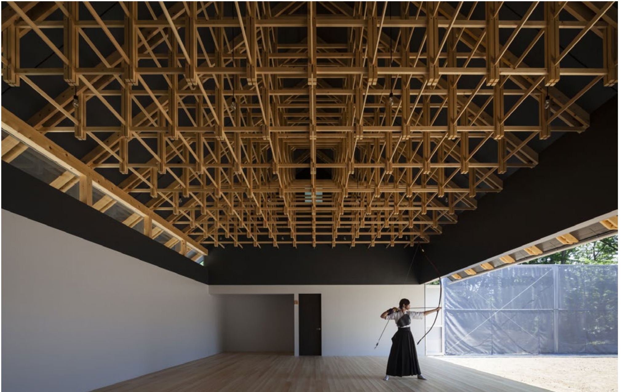
Das Tragwerk der Schießstand-Halle ist filigraner als das der Boxhalle. Für die Konstruktion wurden ehemals insektenbefallene Bäume verwendet. Foto: Shigeo Ogawa
