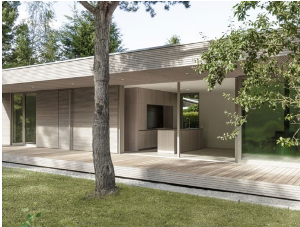
Haus Wandlitz, Fotos: ©2DPLUS
