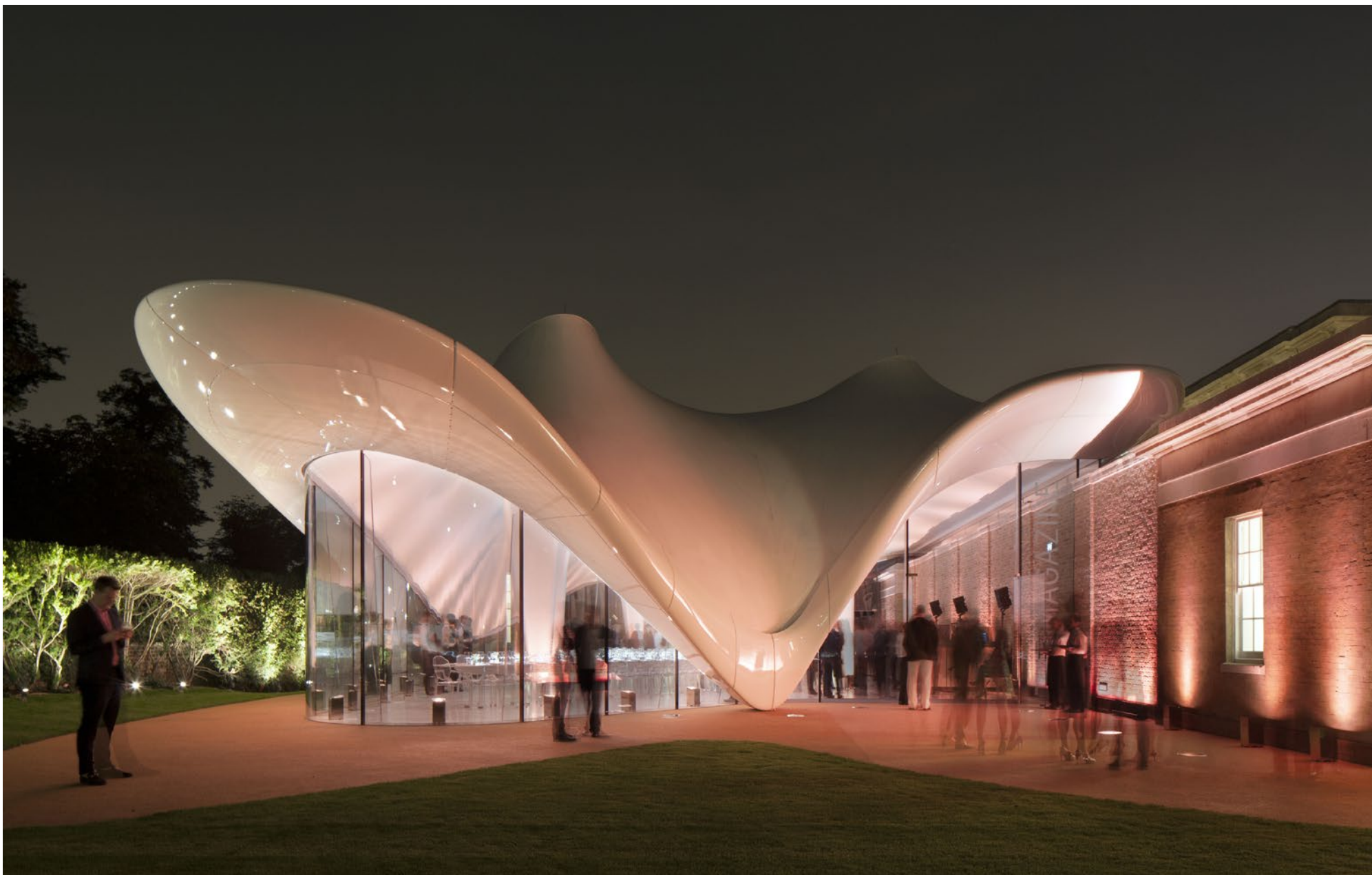
Ein selbsttragendes Dach aus gewebter Glasfaser macht diesen Schwung möglich: Die Serpentine Sackler Gallery von Zaha Hadid Architects, 2013, London, Foto Luke Hayes / RIBA Royal Gold Medal 2016
