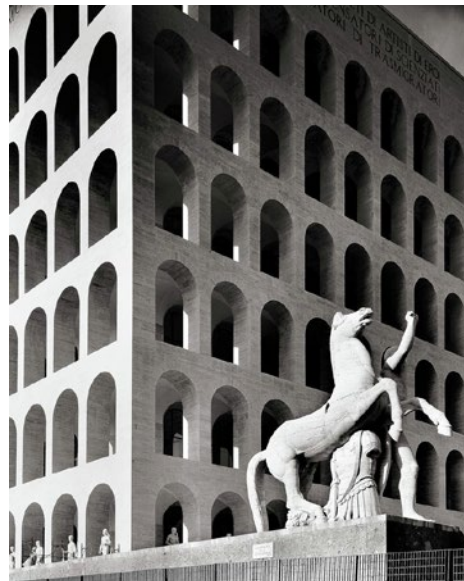
Der Palazzo della Civiltà Italiana, auch Colosseo quadrato genannt, wurde 1938 bis 1943 von den Architekten Ernesto Bruno La Padula, Giovanni Guerrini und Mario Romano im Auftrag Mussolinis gebaut. Im Oktober 2015 ist hier nach langjährigen Sanierungsarbeiten Fendi eingezogen. Foto: foter.com
