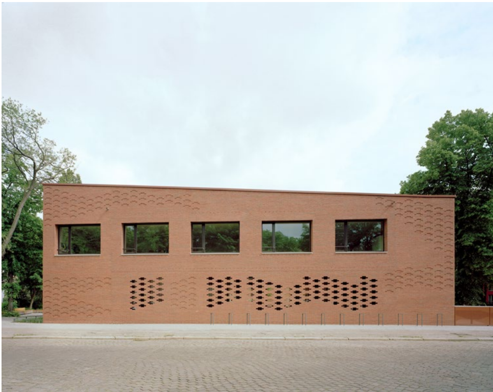
Erweiterungsbau der Ludwig-Hoffmann-Grundschule, Foto: Hans-Christian Schink
