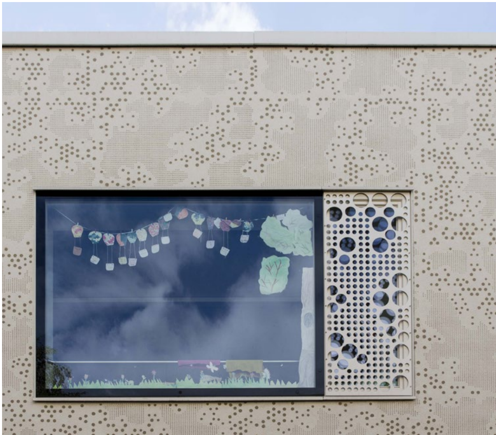
Das schwedische Tarnmuster an der Fassade der Anna-Seghers-Schule ist Graffiti-Schutz und unverkennbares Gestaltungselement.
