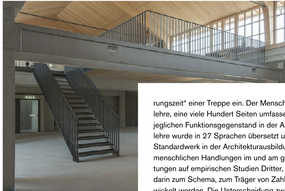
Genormt und industriell gefertigt ist die Treppe in dem Umbau einer Salzburger Panzerhalle von LP Architektur, 2014, Foto: Volker Wortmeyer
