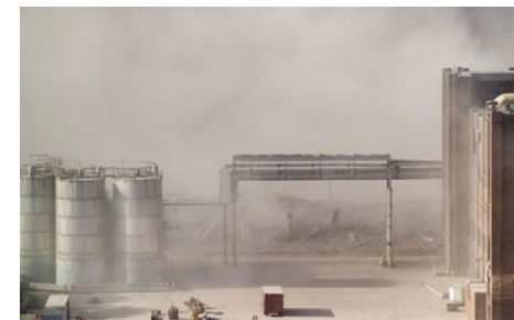
Foto: M. Zellerhoff, Sprengung einer Kodak Fabrik, 2009
